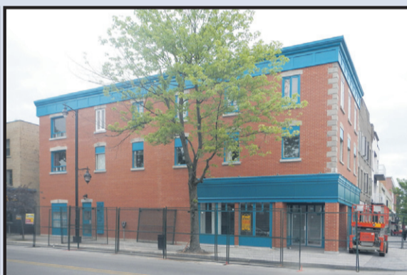
Après les travaux
