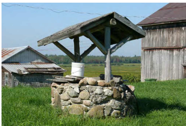
Photo 93 – Puits en pierre au 3580, chemin Bois-Clair à Saint-Antoine-de-Tilly
