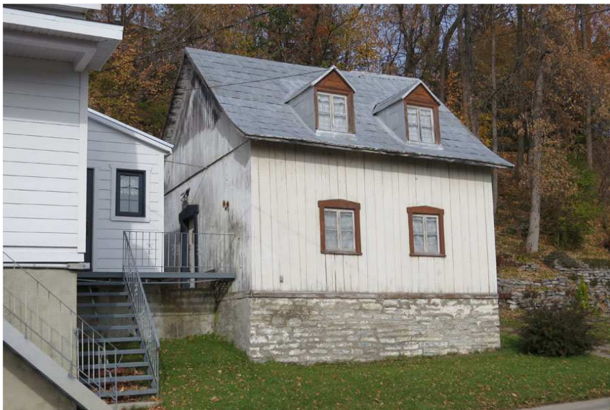
Photo 115 – Fournil avec fondations de pierre relié à la résidence principale, situé au 7825, avenue Royale à Château-Richer, vers 1851-1880
