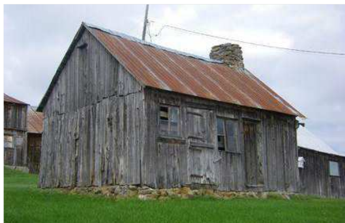
Photo 118 – Fournil revêtu de planches verticales avec fondations en pierres sèches, situé au 418, rang Saint-Pascal aux Éboulements, 2 e moitié du 19 e siècle
