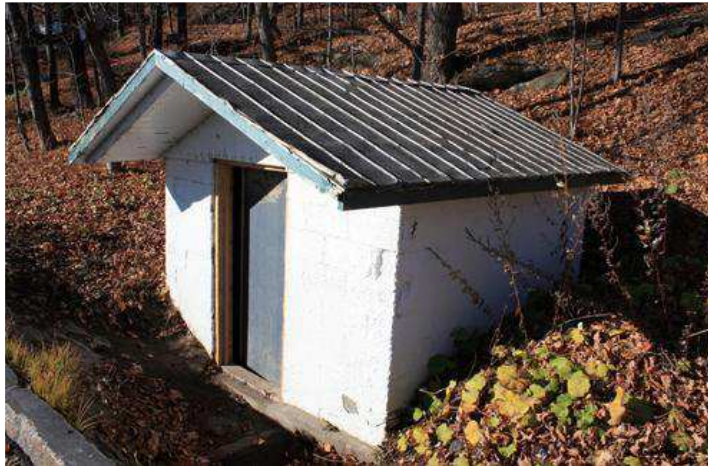
Photo 60 – Caveau disposant d'un toit à deux versants, 8595, avenue Royale à Château-Richer
