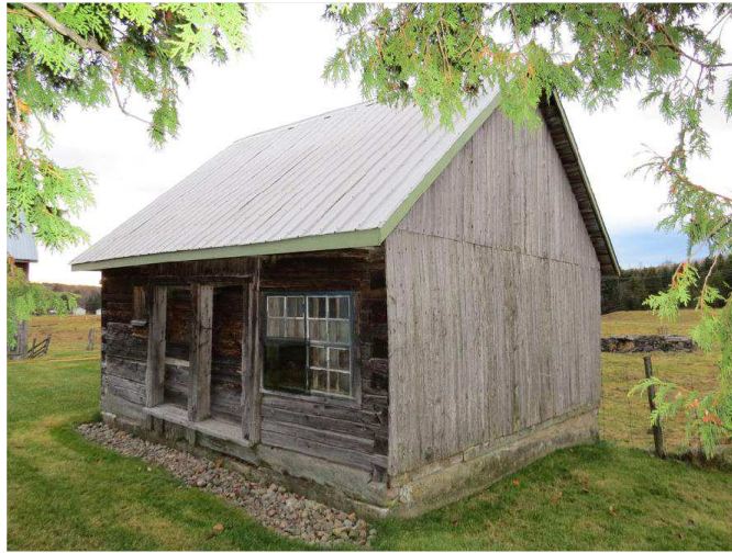
Photo 105 – Remise en pièce sur pièce, située au 264, rang Saint-Elzéar à Saint-Tite-des-Caps, début 20 e siècle
