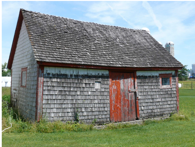
Photo 50 – Porcherie à Saint-Agapit
