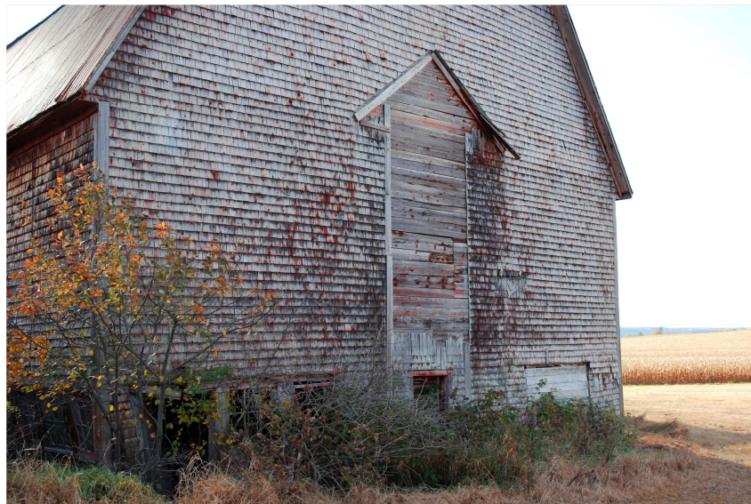
Photo 97 – Traces de l'ancien tambour menant à un silo de bois, sur la grange-étable du 41, chemin de Moe's River à Compton
