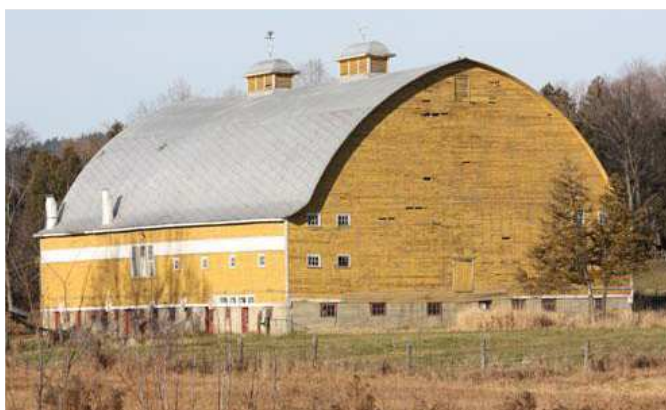
Photo 24 – Grange-étable Pesant à Montebello, 1907
