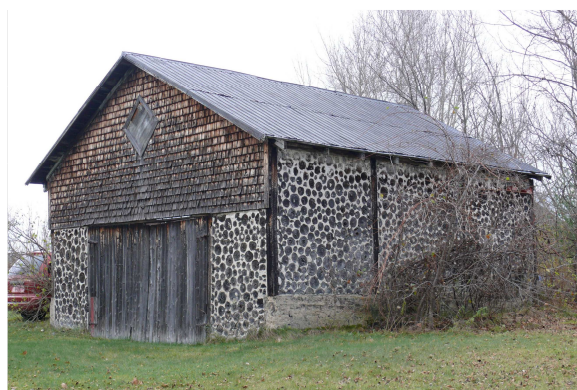
Photo 102 – Hangar au 768, rue Principale à Saint-Janvier-de-Joly, vers 1930-1940
