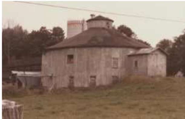
Photo 31 – Grange-étable ronde, située à Hinchinbrooke (Huntingdon)
