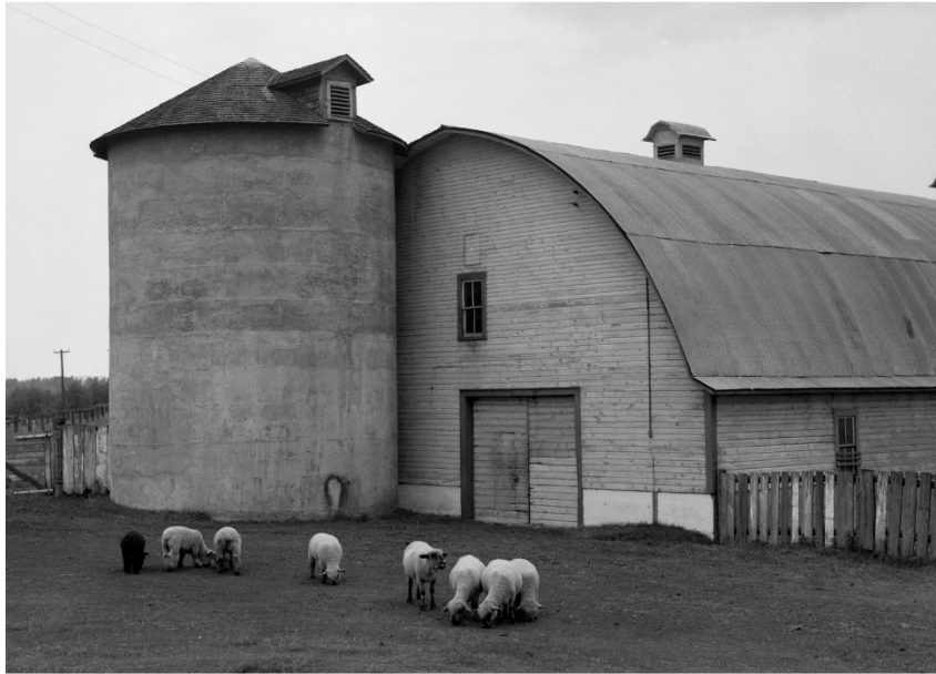
Photo 96 – Silo en béton coulé à Gatineau
