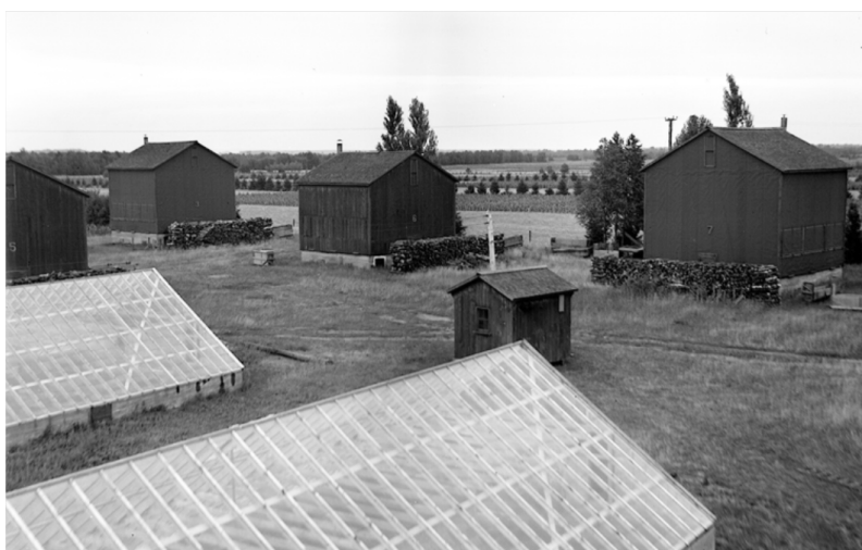
Photo 144 – Séchoirs à tabac et serres chaudes, ferme d'Omer Godbout à Saint-Thomas
