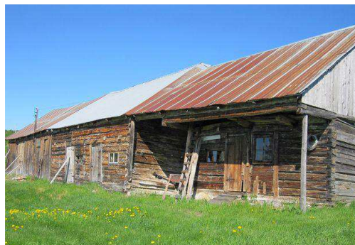
Photo 39 – Grange-étable à encorbellement du 30, rang Saint-Antoine à Saint-Ferréol-les-Neiges, avant 1900
