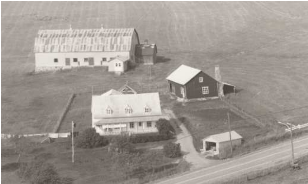
Photo 114 – Fournil situé à droite de la résidence à Charlevoix-Est
