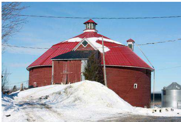
Photo 32 – Grange-étable ronde Stanley-Holmes, encore en fonction, située à Barnston-Ouest
