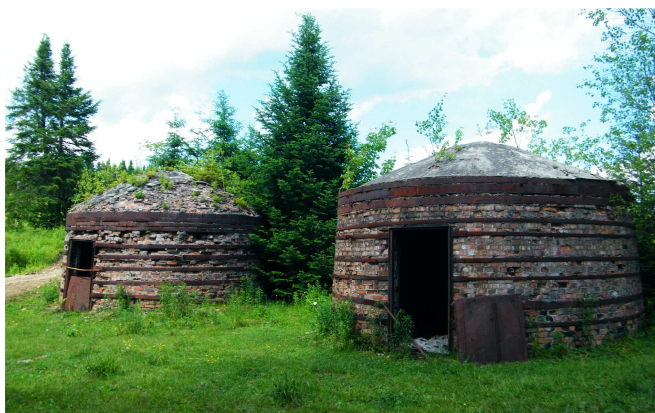
Photo 125 – Four à charbon à Saint-Léonard-de-Portneuf
