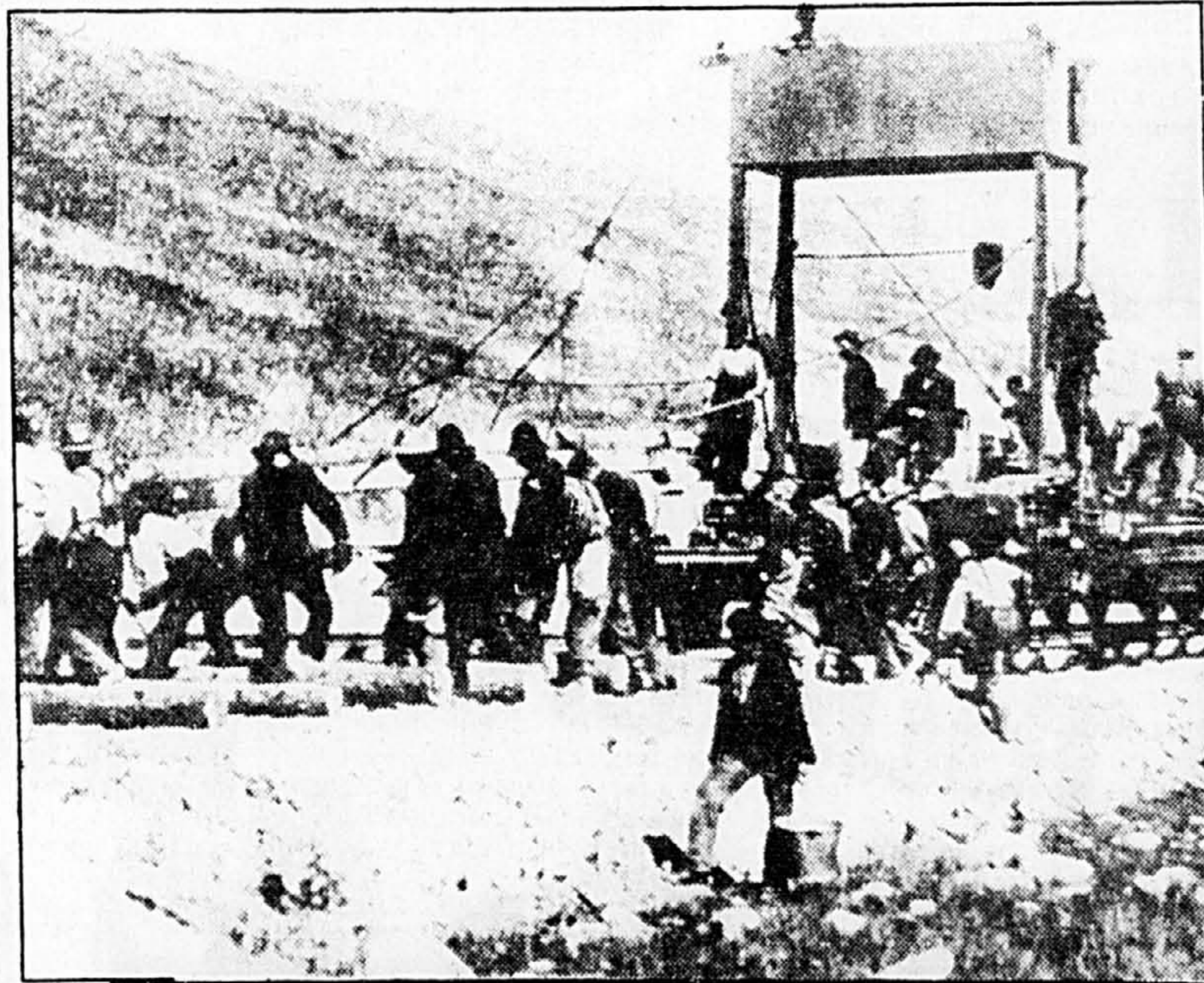
Une des premières machines utilisées pour la pose de la voie ferrée, au cours des années 1880.
