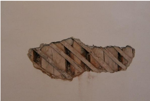
Mur de grumes des cellules du monastère de l'Hôtel-Dieu de Québec Photo : ABCP architecture, 2012
