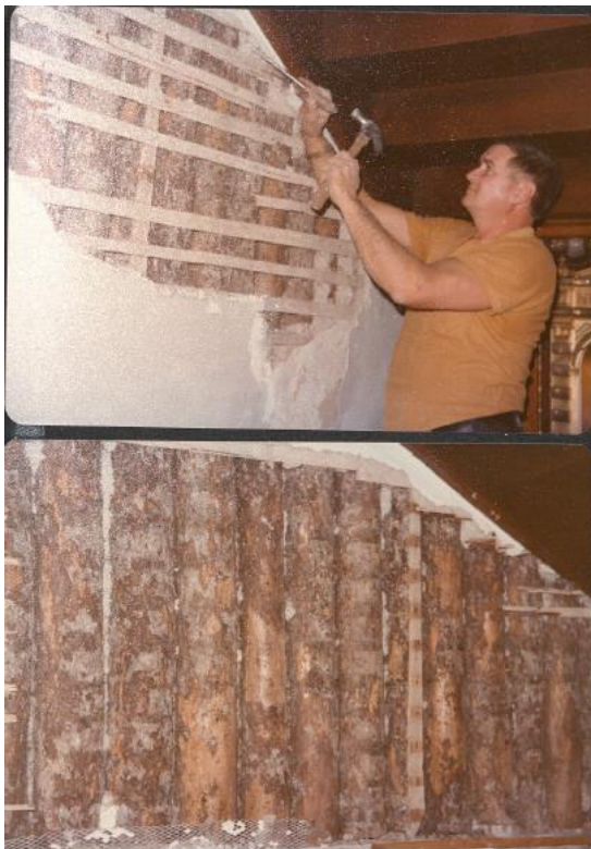
Travaux de restauration de la cloison entre le réfectoire des Récollets et le carrefour de l'escalier en 1979. Sources : Le Monastère des Augustines, HG-A-26.23.11.2
