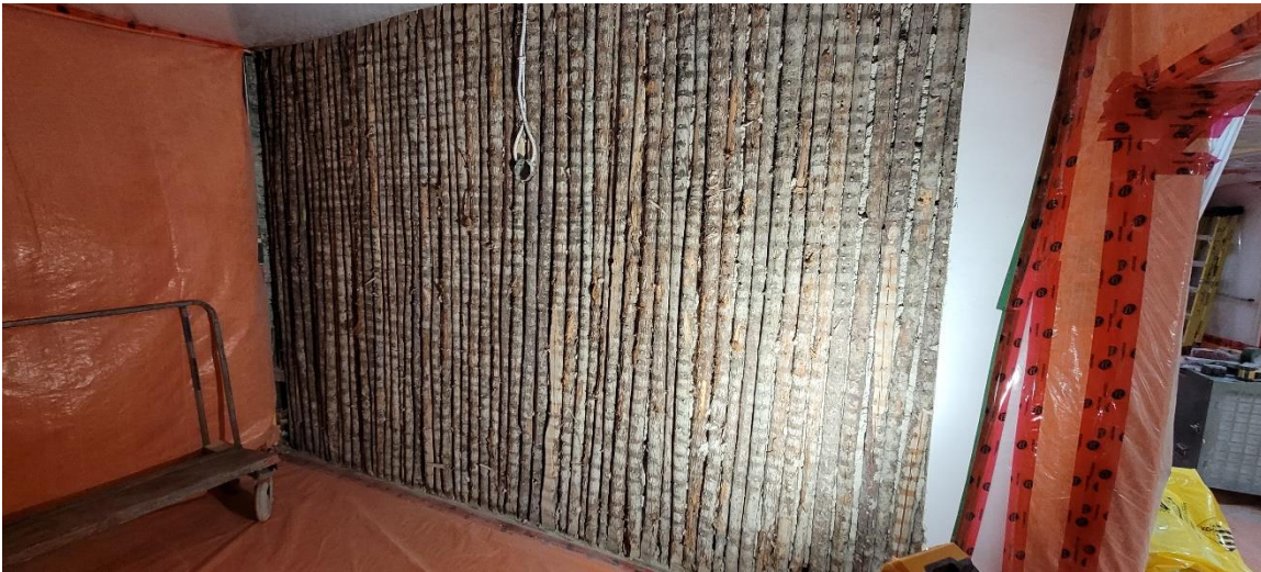
Cloison de grumes sans son crépi, entre deux cellules de religieuses, monastère de l'Hôpital général de Québec. Photo : Mélanie Tremblay, 2022.
