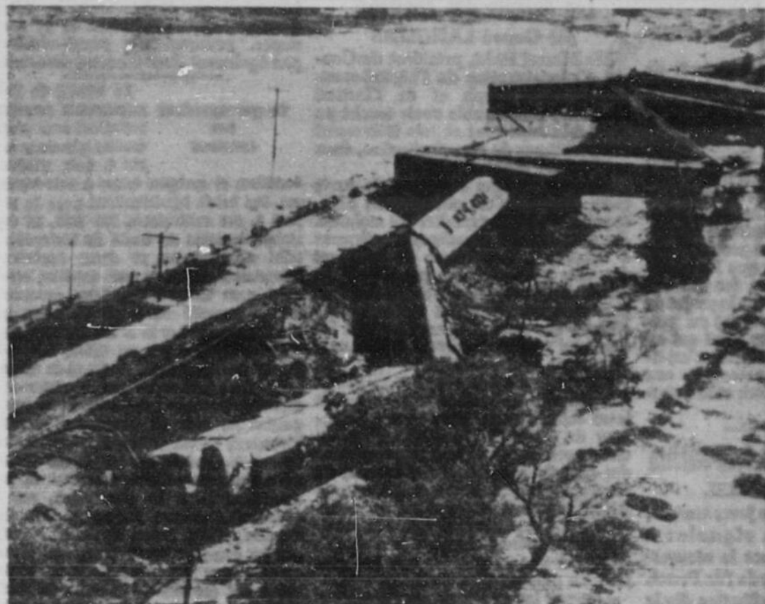
UN MORT, ONZE BLESSES DANS CET ACCIDENT FERROVIAIRE. — Une personne a perdu la vie et onze autres ont été blessées quand ce convoi du chemin de fer "Union Pacific" a sauté de la voie près de Fort Morgan, dans le Colorado. Trois unités "Diesel" et dix wagons ont ainsi quitté les rails quand ceux-ci cédèrent par suite du sol détrempé par les pluies récentes. Le convoi effectuait alors un détour pour éviter de traverser un autre secteur où les pluies avaient trop fortement détrempé le sol.
