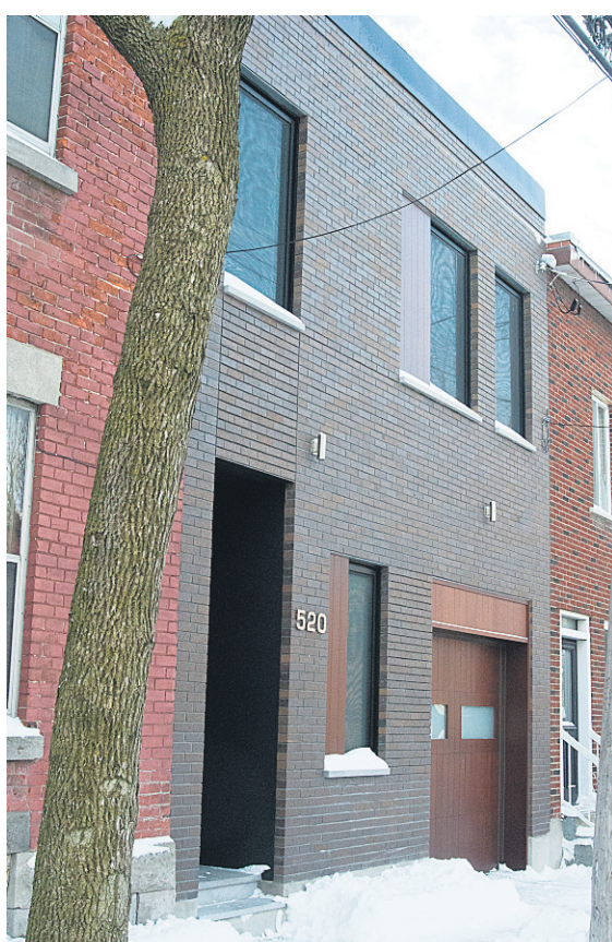
De la brique chocolat habille la façade de la maison, avec des insertions de panneaux de bois et une porte de garage assortie.
