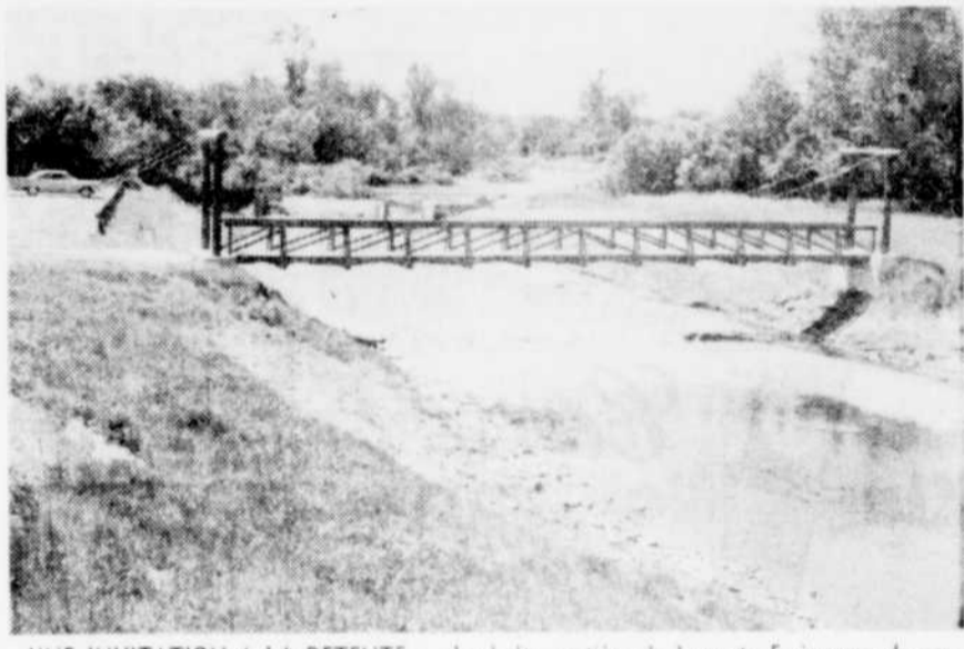
UNE INVITATION A LA DETENTE — La halte routière de la route 5, à cause de ses nombreuses opportunités et de son accessibilité facile, sera un lieu de repos très apprécié par les gens de la région au cours de l'été. A certaines périodes de la fin de semaine, on pouvait y apercevoir plusieurs dizaines de personnes. (Photo La Tribune, Victoriaville)
