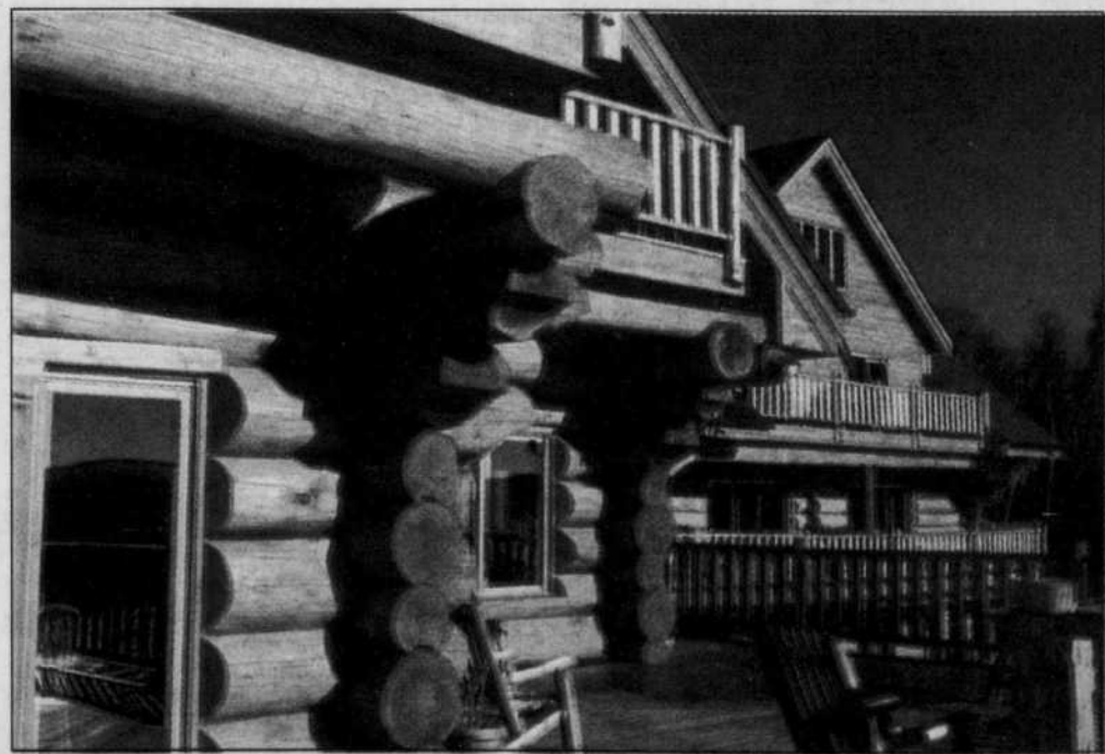
Bois rond et poutres techniques pour cette énorme bâtisse qu'est l'hôtel Sacacomie.
