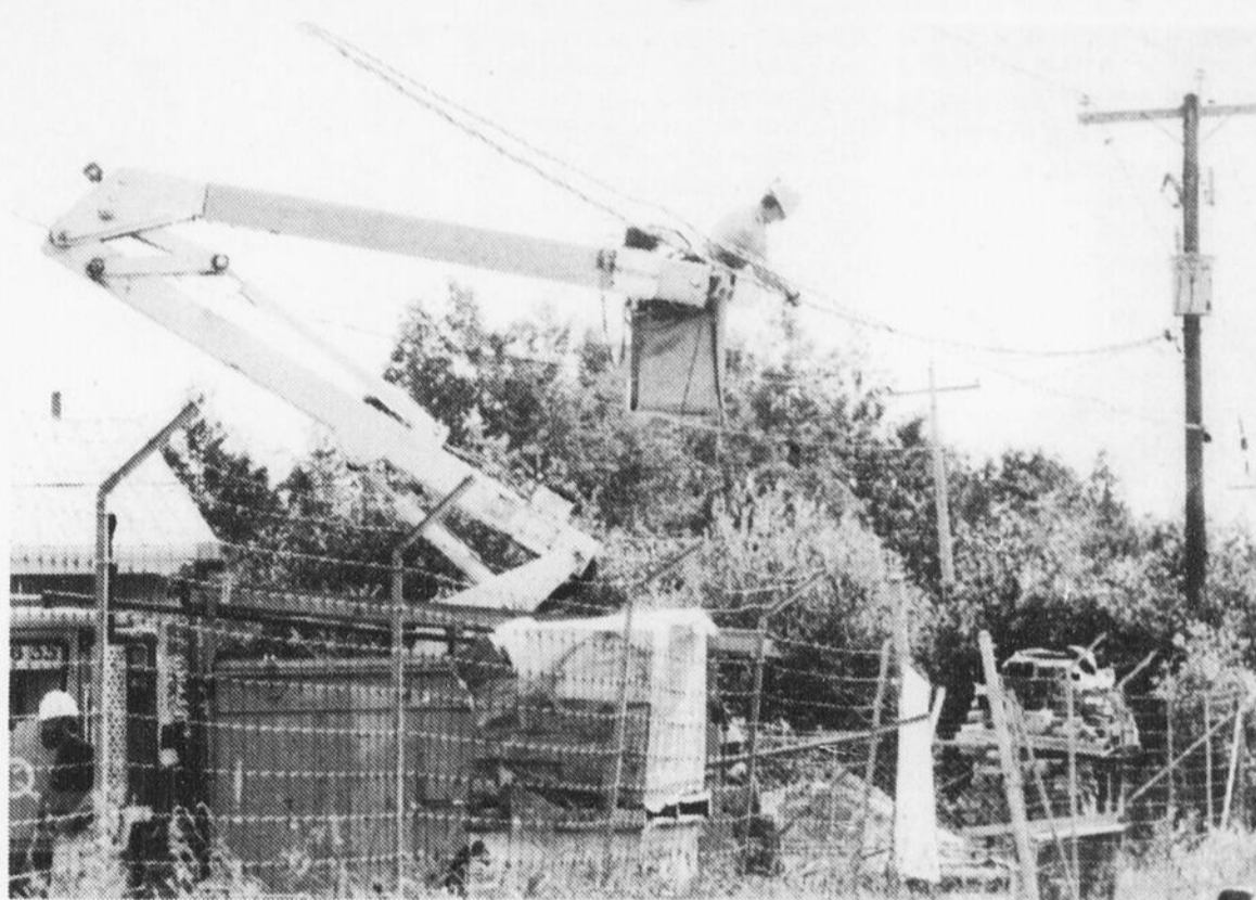
REPARATION - Un employé de l'Hydro-Québec travaille à rétablir le courant, à la suite du drame survenu hier, à Chicoutimi, secteur nord.
