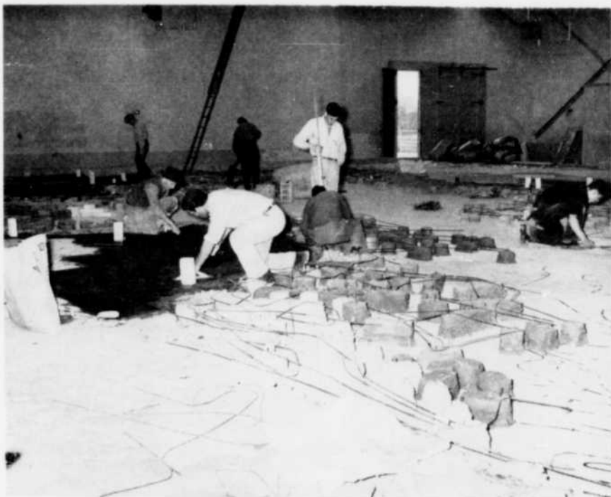
Mise en place des barres de contours à leur élévation respective.
