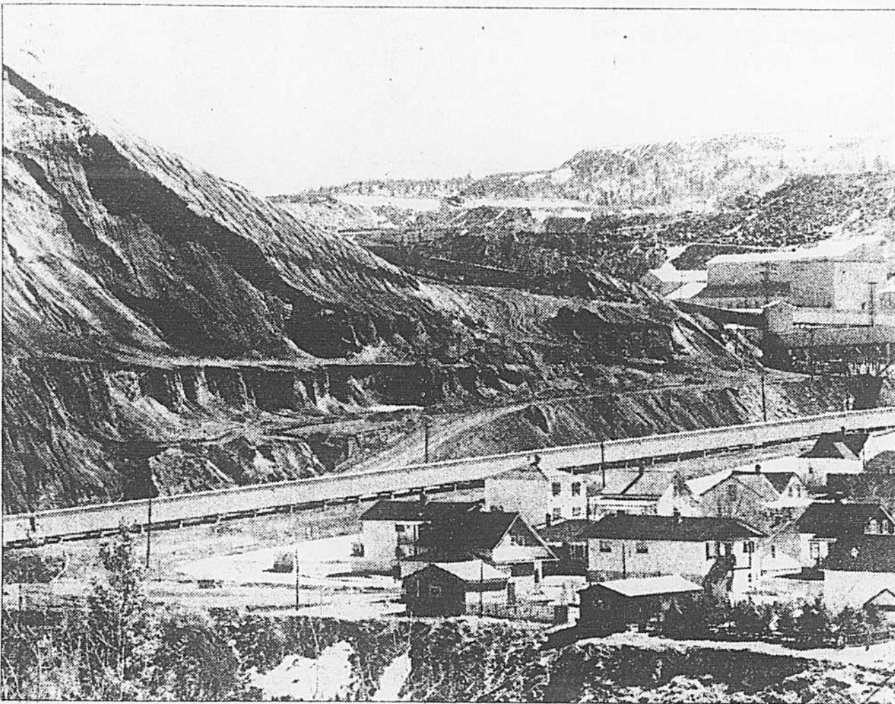
Extraction de l'amiante à Thetford Mines.
