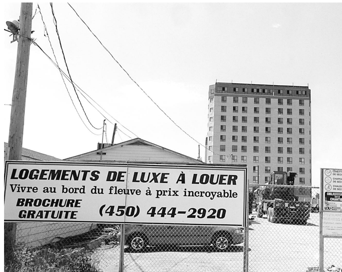
Outre son chantier de Dollard-des-Ormeaux, Solitec construit aussi un immeuble de logements à Brossard, où la CSST et la CCQ ont constaté des irrégularités.
