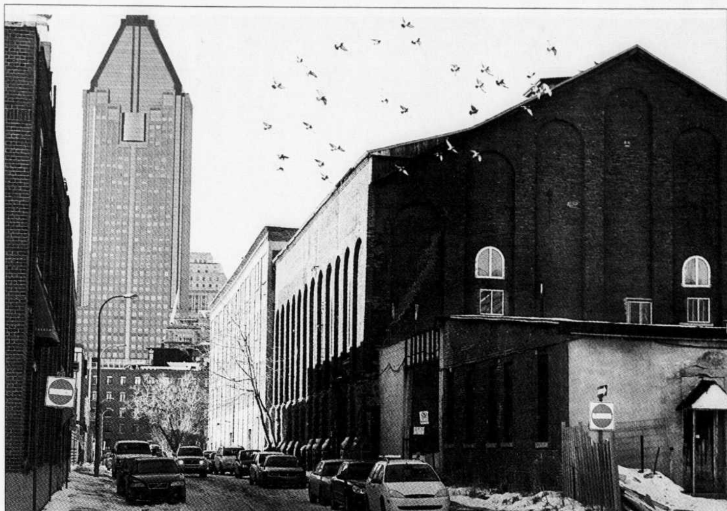
Le quartier Griffintown demande que le patrimoine soit pris en compte dans sa diversité, qu'on vise une revitalisation véritable fondée sur l'intensification des usages dans un bâti diversifié plutôt qu'une densification monochrome et, enfin, qu'on adopte une vision d'aménagement du secteur en relation avec le Vieux-Montréal, le centre-ville et les quartiers voisins.
