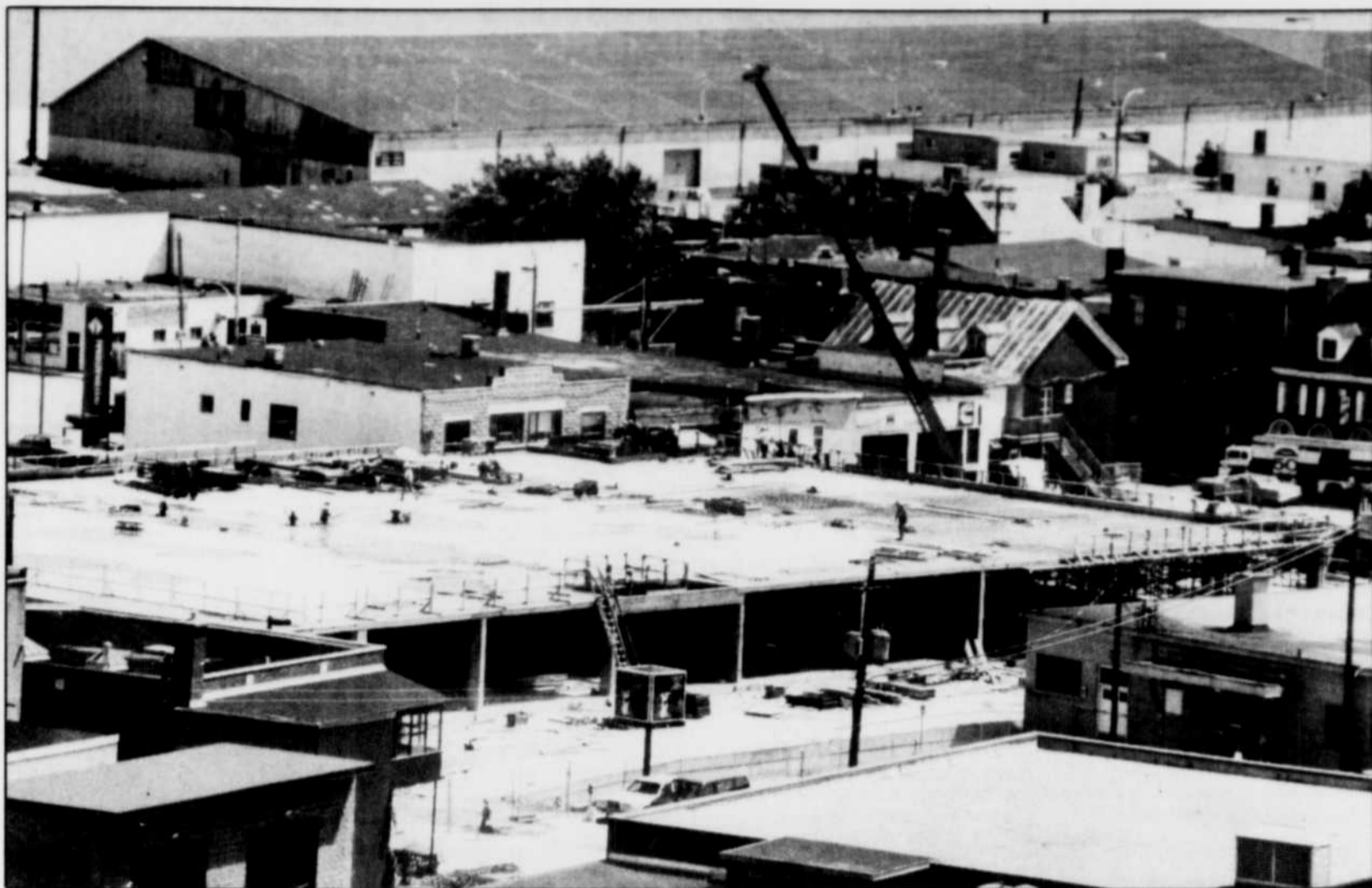
La chantier de la Place du Marché, au centre-ville de Trois-Rivières, progresse à un bon rythme depuis le début d'avril. Les ouvriers doivent s'attaquer, lundi, à l'érection de la charpente d'acier, une dizaine
