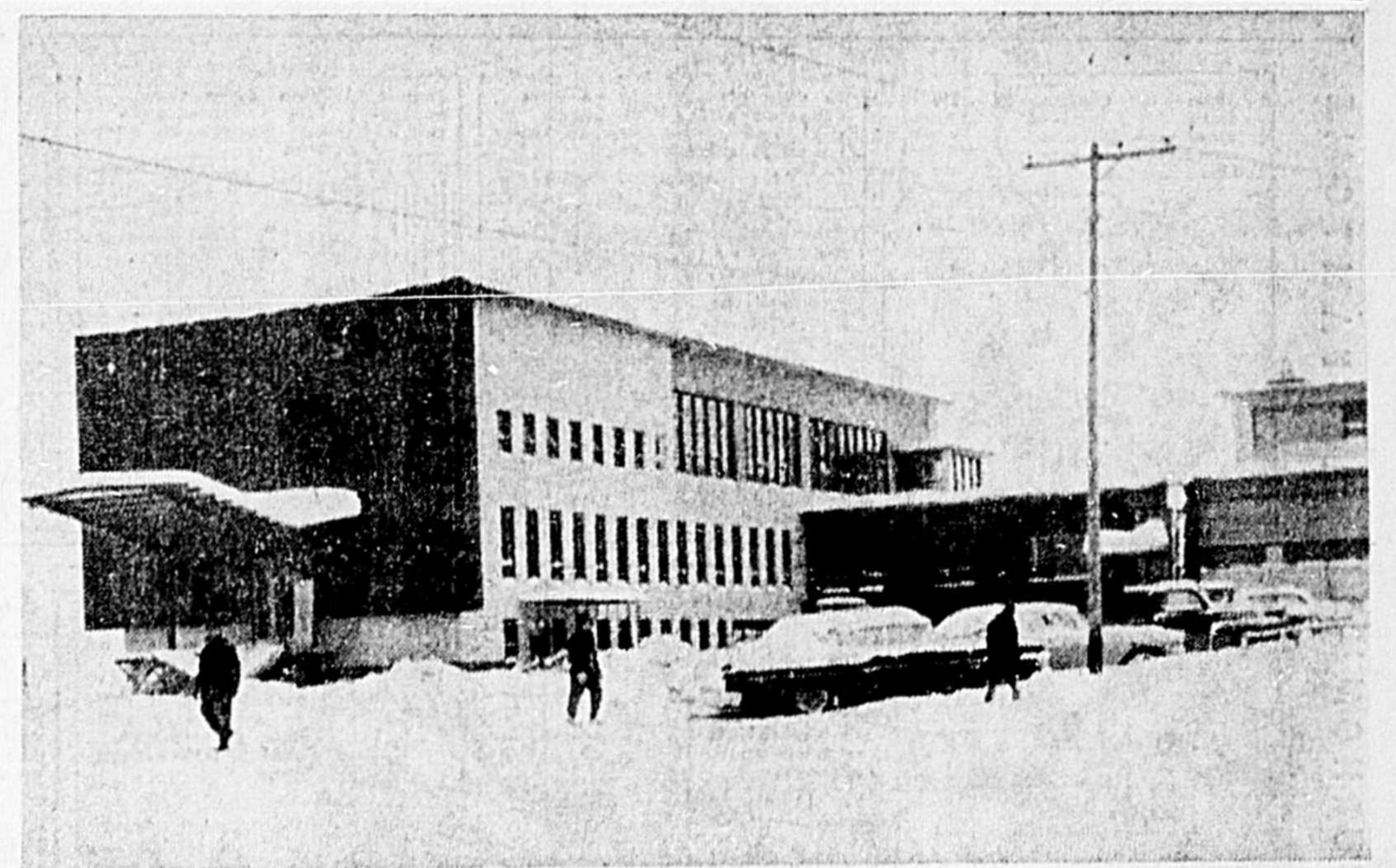
UN DEUXIEME PAVILLON AU COLLEGE DE JONQUIERE: — La construction par les entrepreneurs Bouchard et Gravel d'un deuxième pavillon commence déjà à donner de l'ampleur au plan d'ensemble projeté qui comprend cinq pavillons et dont les parachèvements sont prévus pour 1960. Les travaux ont débuté le 15 août et l'extérieur est complètement terminé; tandis que les travaux de finition intérieure devraient être complétés vers le 15 janvier, au plus tard. Toutefois, notons que les Rds. Pères Oblats, qui dirigent cette institution d'études secondaires, résident déjà au troisième étage temporairement, puisque ces locaux sont destinés à l'installation définitive d'une bibliothèque publique. Le rez-de-chaussée sera occupé par les bureaux d'administration et la chapelle, tandis que le sous-sol est réservé aux cuisines et à un caféteria pour les élèves. Le coût de construction est de l'ordre de $250,000. (Photo Le Progrès)
