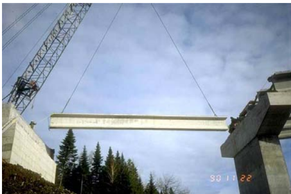
11. Mise en place d'une poutre préfabriquée
