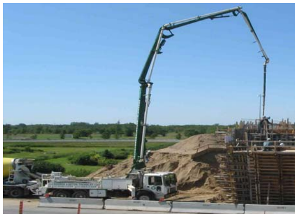
19. Pompe à béton
