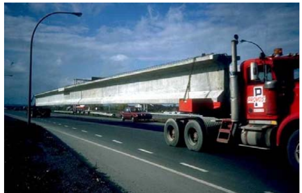
10. Transport d'une poutre préfabriquée
