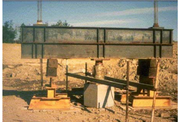
20. Essai de chargement : banc ancré à l'aide de tiges d'ancrages au roc
