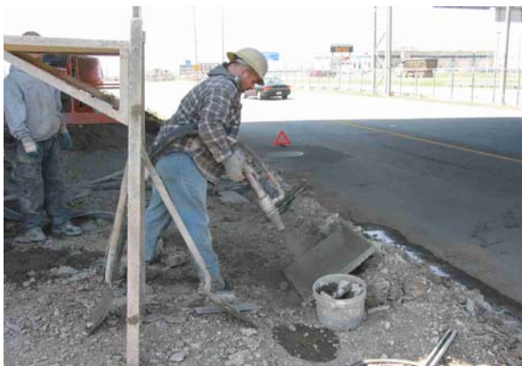
5. Projection d'un échantillon de béton
