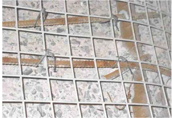
2. Fixation du treillis métallique
