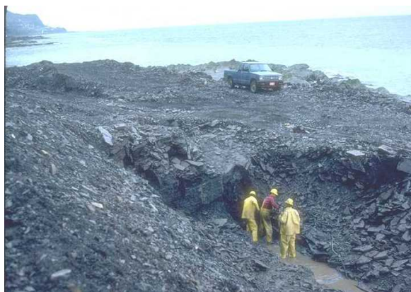
2. Excavation de première et deuxième classe selon la technique utilisée
