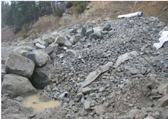
21. Revêtement en pierres lors de la construction
