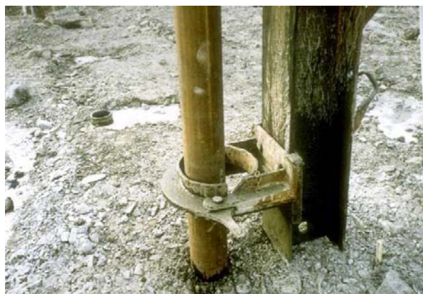
6. Guide d'alignement sur la jumelle
