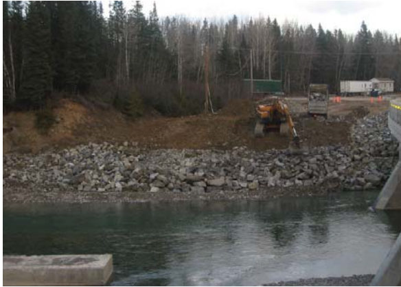
19. Mise en place de pierres avec une pelle hydraulique
