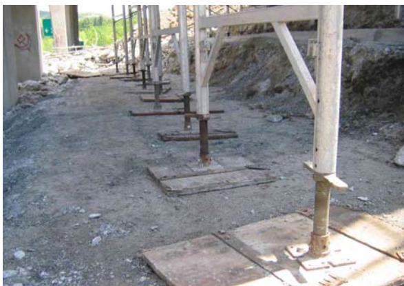
11. Détail de la base des étais (poteaux)
