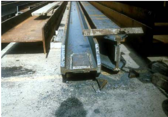
1. Pieux en H
