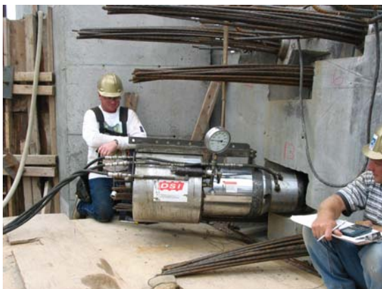
5. Mise en tension des armatures de précontrainte
