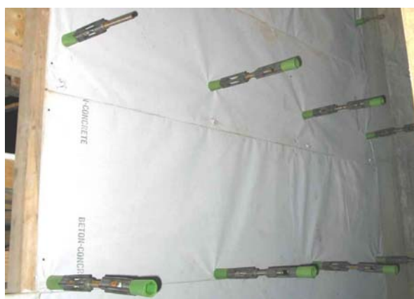
3. Doublure de coffrage, repliée sur chaque panneau
