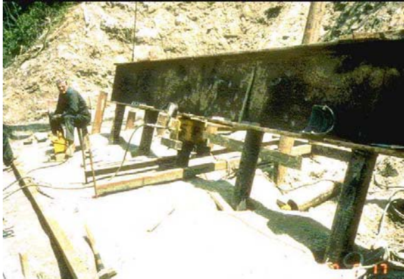
19. Essai de chargement : banc ancré sur pieux adjacents
