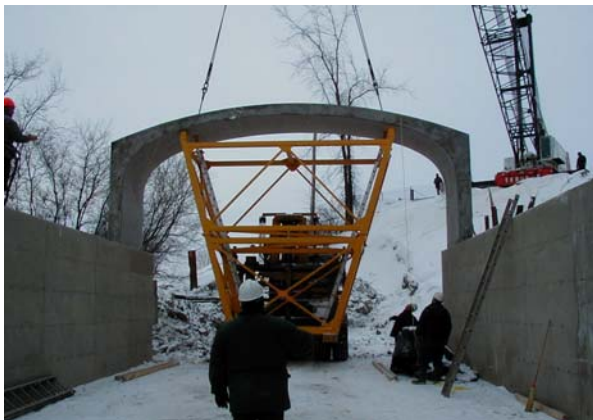
1. Installation d'un tuyau en béton armé (TBA)
