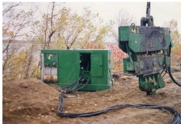
10. Vibrofonneur utilisé pour le fonçage des palplanches métalliques
