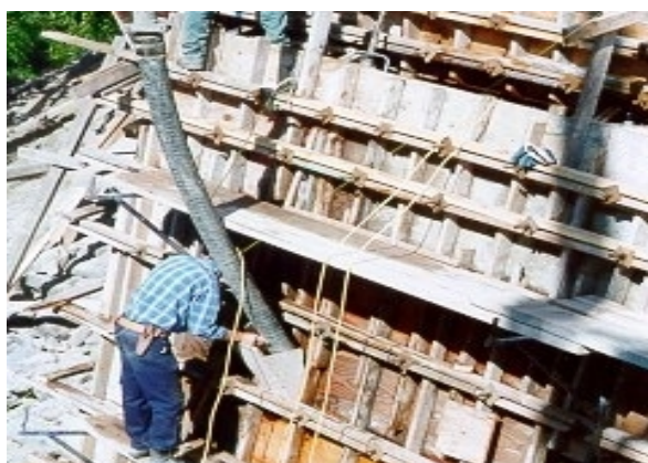
23. Bétonnage au moyen d'ouvertures temporaires dans les coffrages
