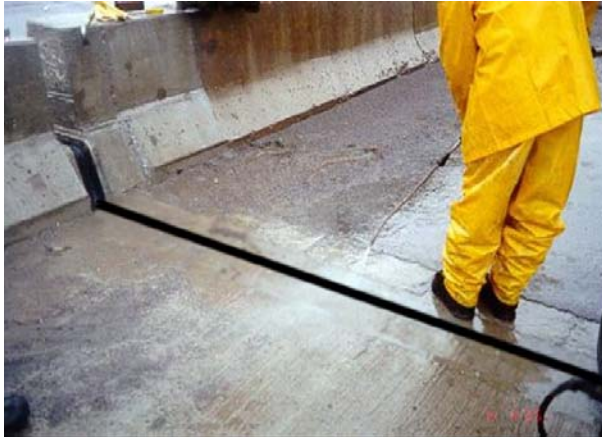
7. Essai d'étanchéité d'un joint de tablier
