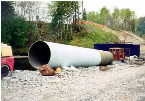
3. Pieu caisson (tube métallisé)
