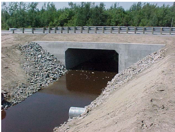
5. Ponceau rectangulaire en béton armé
