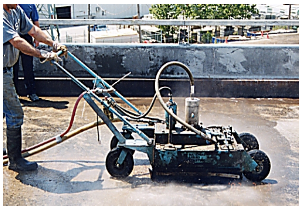
1. Nettoyage de base d'une dalle existante (eau sous pression)
