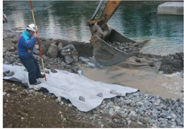
20. Mise en place d'un géotextile sous le revêtement en pierres
