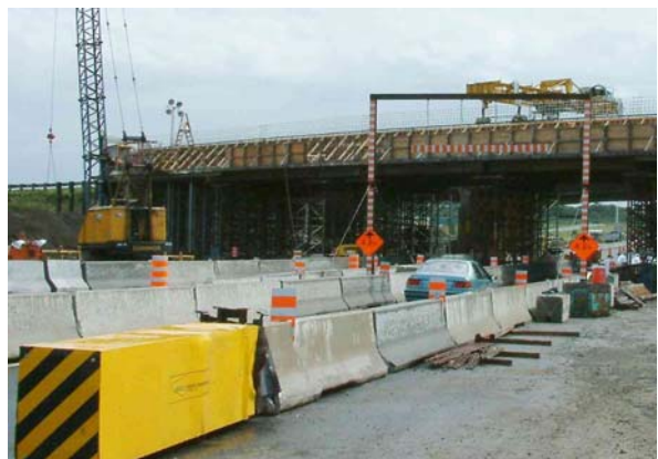
12. Protection d'étalement avec gabarit et glissières
