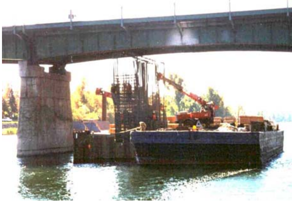
7. Accès à partir d'une barge
