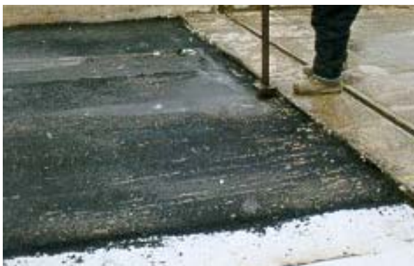
5. Compactage près d'un joint de tablier
