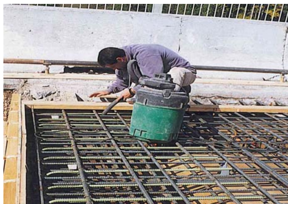
18. Nettoyage final des coffrages
