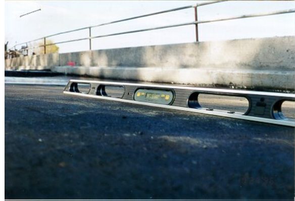
8. Vérification de profils avec niveau électronique
