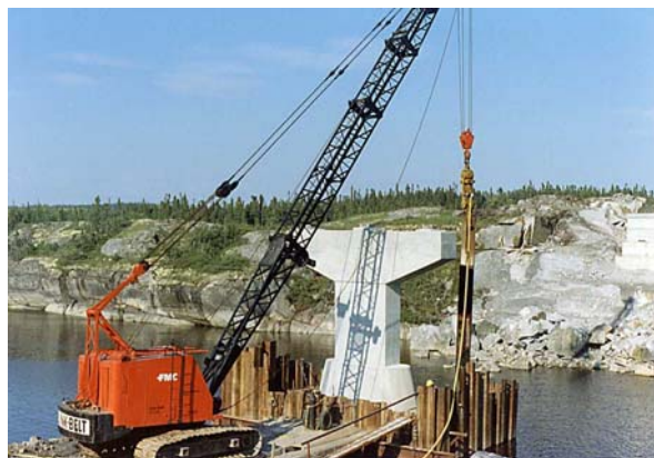
14. Enlèvement des palplanches métalliques
