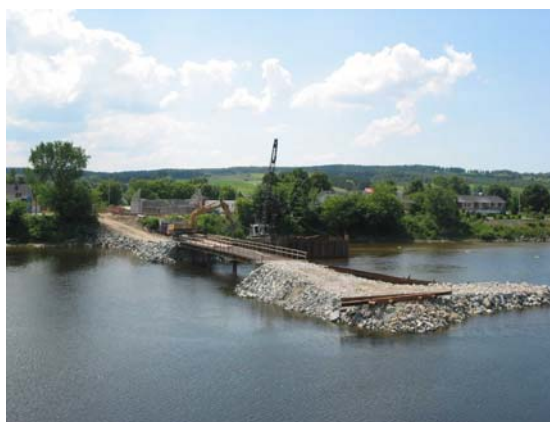
6. Chemin d'accès avec pont temporaire
