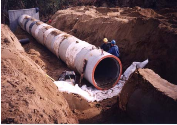
1. Installation d'un tuyau en béton armé (TBA)
