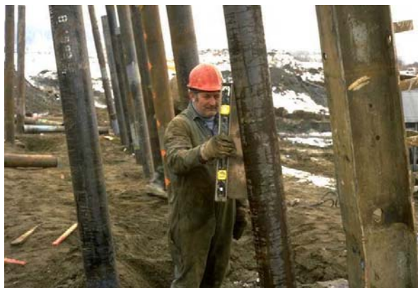
13. Contrôle de la pente des pieux battus
