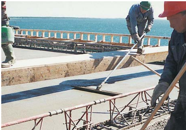
33. Finition de la dalle sur plate-forme
