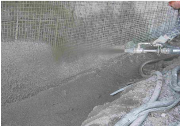
7. Technique de projection adéquate
