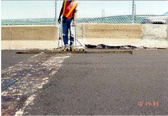
7. Vérification du profil vis-à-vis d'un joint de tablier (règle de 3 m)
