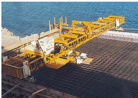
28. Finisseur à béton automatique
