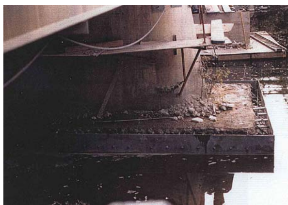
42. Coffrage métallique pour bétonnage sous l'eau
