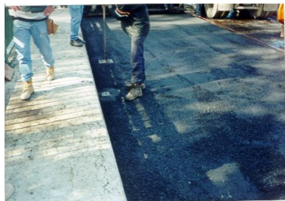
6. Compactage près d'un drain
