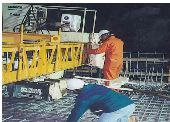
30. Ajustement du finisseur à béton automatique
