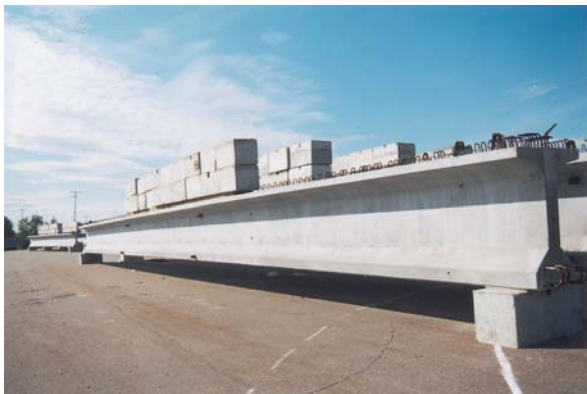
9. Chargement de poutres préfabriquées
