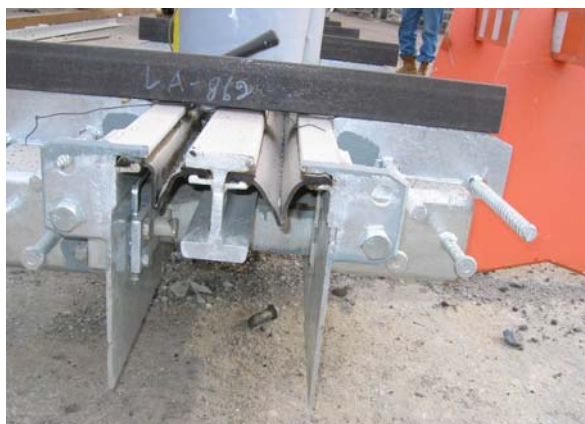
6. Joint de tablier à plus d'une garniture
