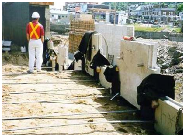
6. Mur remblai renforcé par des armatures en acier avec paroi en béton armé
