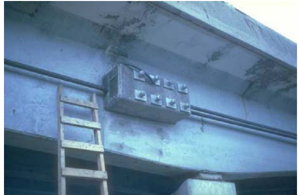
8. Précontrainte extérieure (renforcement)
