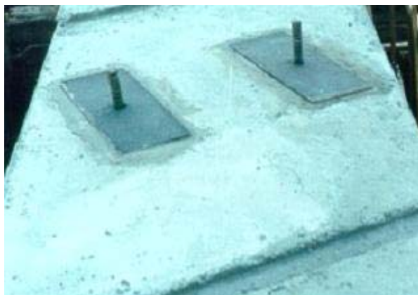
3. Appareils d'appui en élastomère fretté fixes pour poutres en béton
