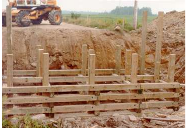
2. Début de construction d'un caisson
