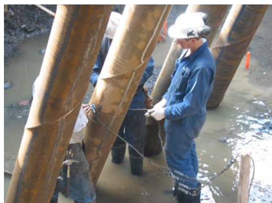
16. Instrumentation d'un pieu pour l'essai dynamique
