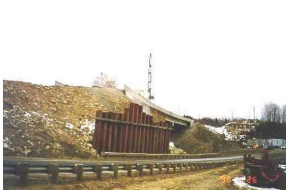
17. Soutènement temporaire en palplanches métalliques
