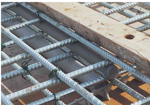
35. Boudins pour joint de construction d'urgence
