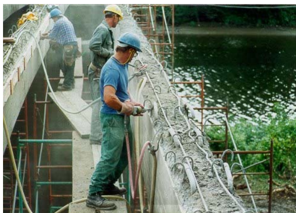
3. Démolition partielle avec marteaux pneumatiques 7 kg
