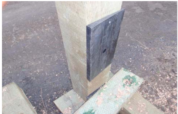
4. Espaceur pour pont avec biais
