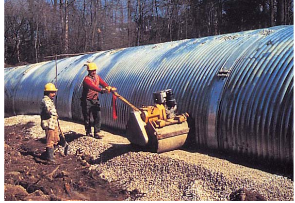
2. Compactage au début de la construction d'un tuyau en tôle ondulée aluminisée
