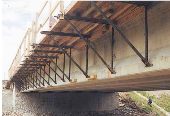
8. Supports de coffrages de dalle en porte-à-faux
