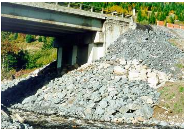
23. Revêtement en pierres sur un remblai d'approche
