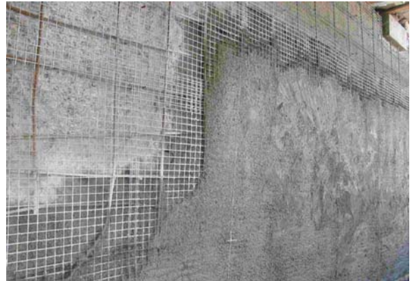
8. Travaux de projection en cours de réalisation
