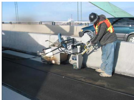
4. Petit équipement de pose mécanisé utilisé près des bordures
