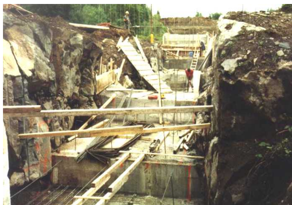
1. Excavation de première classe en paliers
