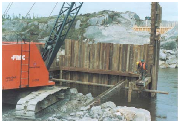
12. Fonçage de palplanches métalliques à l'aide d'un marteau
