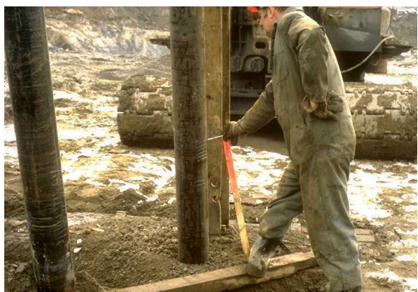
15. Mesure de l'enfoncement d'un pieu battu
