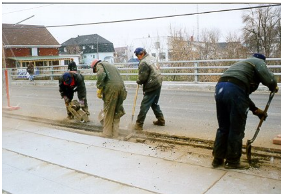
11. Sciage d'un joint froid (travaux en phases)
