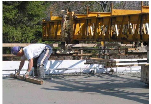
34. Finition manuelle des abords de dalle
