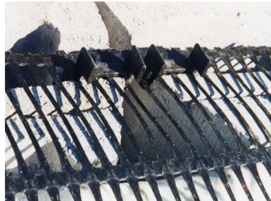
4. Connexion mécanique des géogrilles aux blocs remblai
