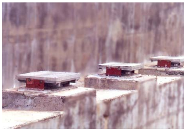
2. Appareils d'appui à élastomère confiné (guidés) sur blocs d'assise
