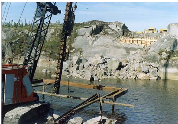
11. Mise en place du cadre guide pour le fonçage des palplanches métalliques
