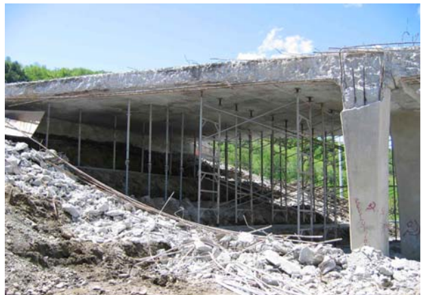
10. Étalement (travaux d'entretien)
