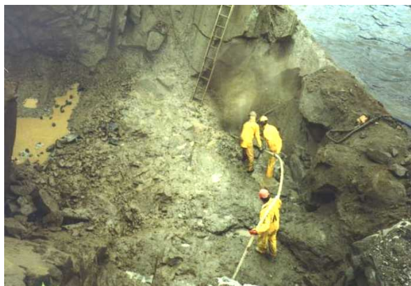
3. Nettoyage de la surface du roc
