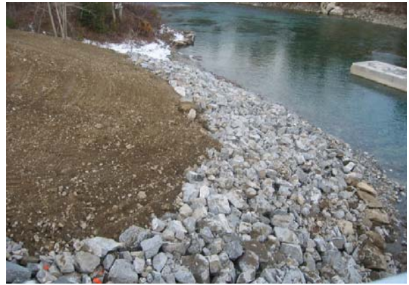
22. Revêtement en pierres finalisé
