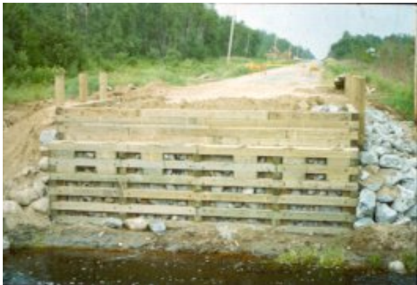
3. Culée de type caisson
