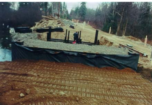
5. Remplissage des excavations à l'arrière d'une culée de type caisson
