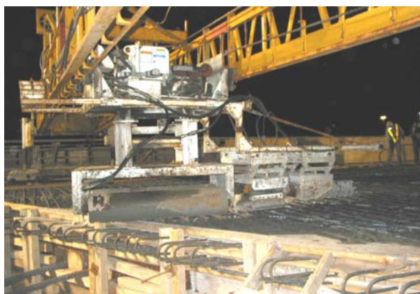
29. Détail du module mobile du finisseur automatique
