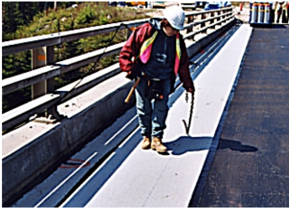
7. Vérification de l'adhérence de la membrane (chaîne)
