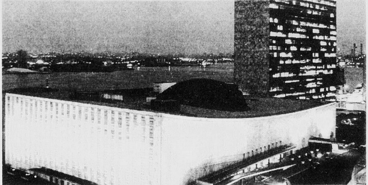
NATIONS UNIES — Quatre bâtiments composent le Palais des Nations unies. On voit sur cette photo la Tour du secrétariat (à l'arrière), qui abrite les 7,075 fonctionnaires
