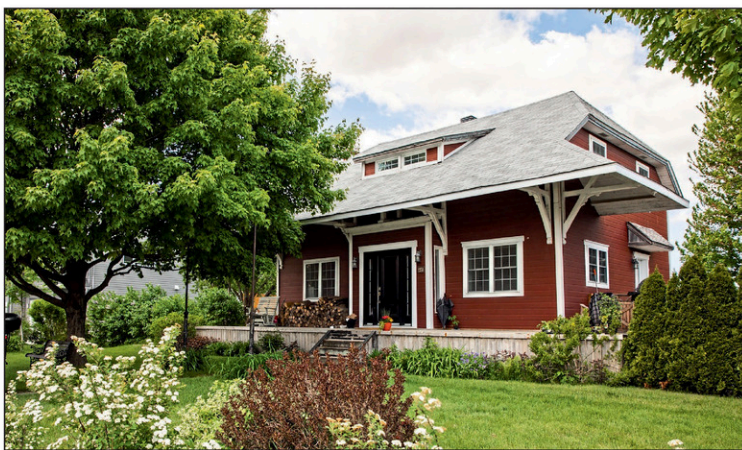
Grâce à Roger Brosseau et à sa femme Jeanne-d'Arc Desgagné, la gare constitue un bel exemple de préservation de notre patrimoine ferroviaire.
