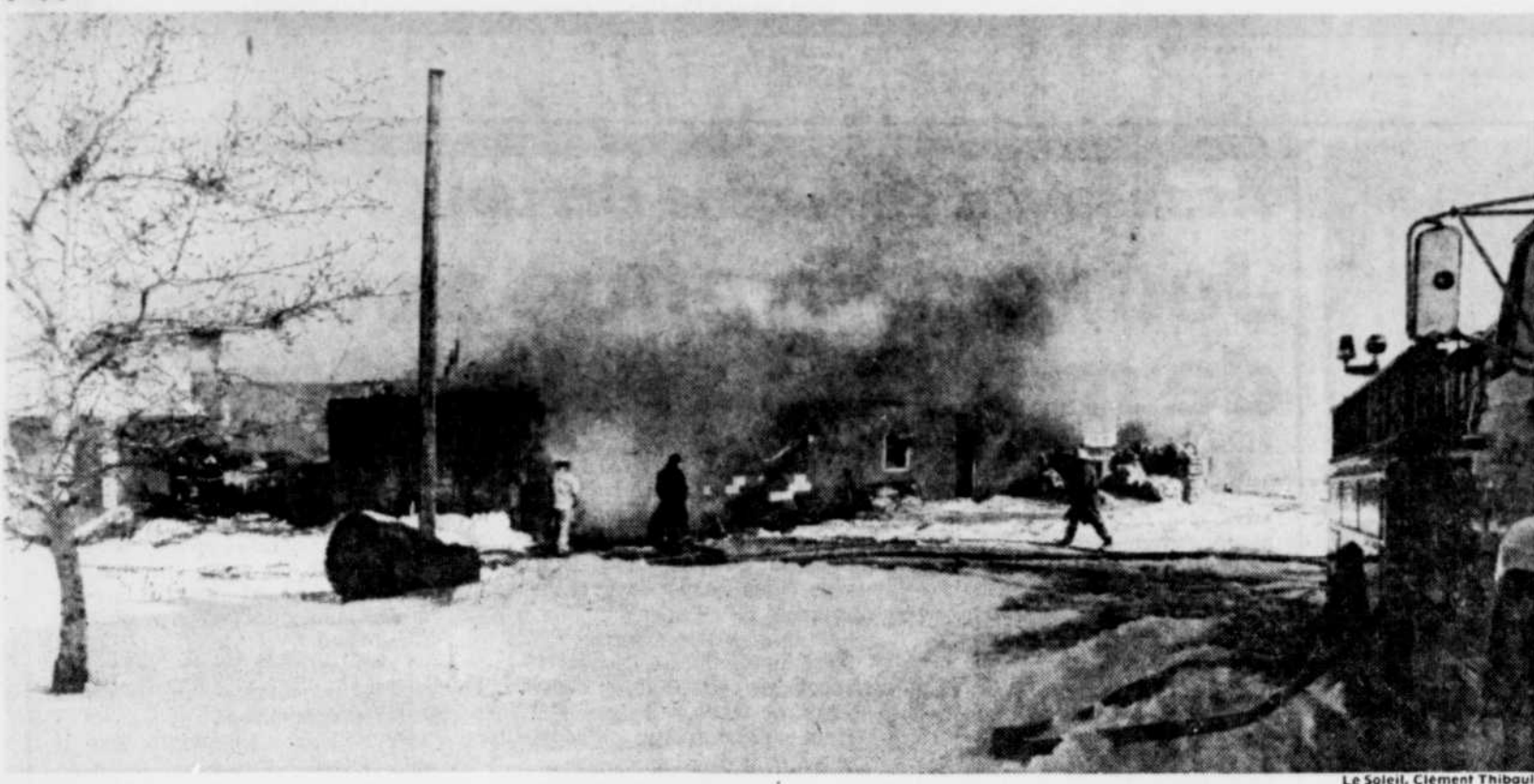
L'usine de préparation de pommes de terre, un bâtiment mesurant 30 mètres par 37,5 mètres, est une perte totale.
