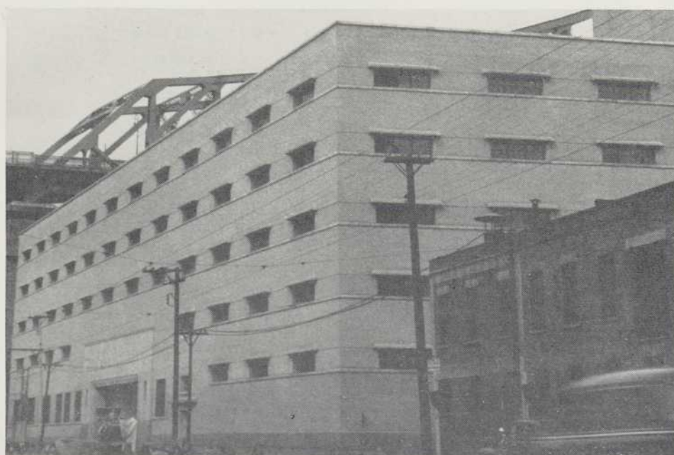
VUE DE L'ENTREPOT, RUE CRAIG EST
