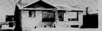
MELOCHEVILLE : Si... spacieuse, si... claire, si... aérée avec parquetterie. Sous-sol fini. Taxes basses!
