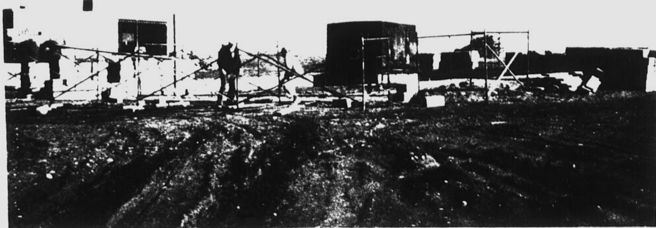
Une nouvelle fromagerie, propriété de M. Vianey Choquette, est en construction sur la rue Laval-Nord.
