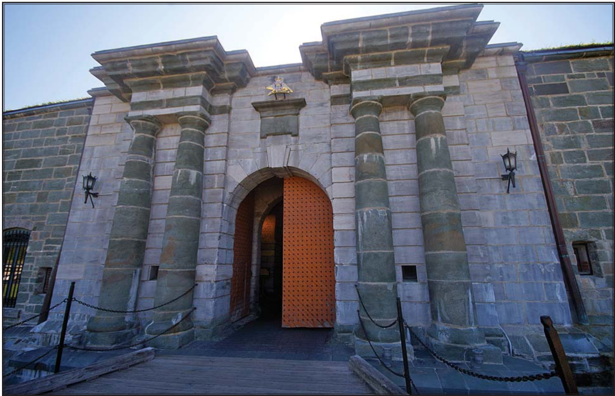
Porte Dalhousie construite en 1827 : colonnes toscanes et corniches en grès de Sillery, mur à l'arrière des colonnes en calcaire de Pointe-aux-Trembles et murs aux extrémités gauche et droite en grès de Sillery.
