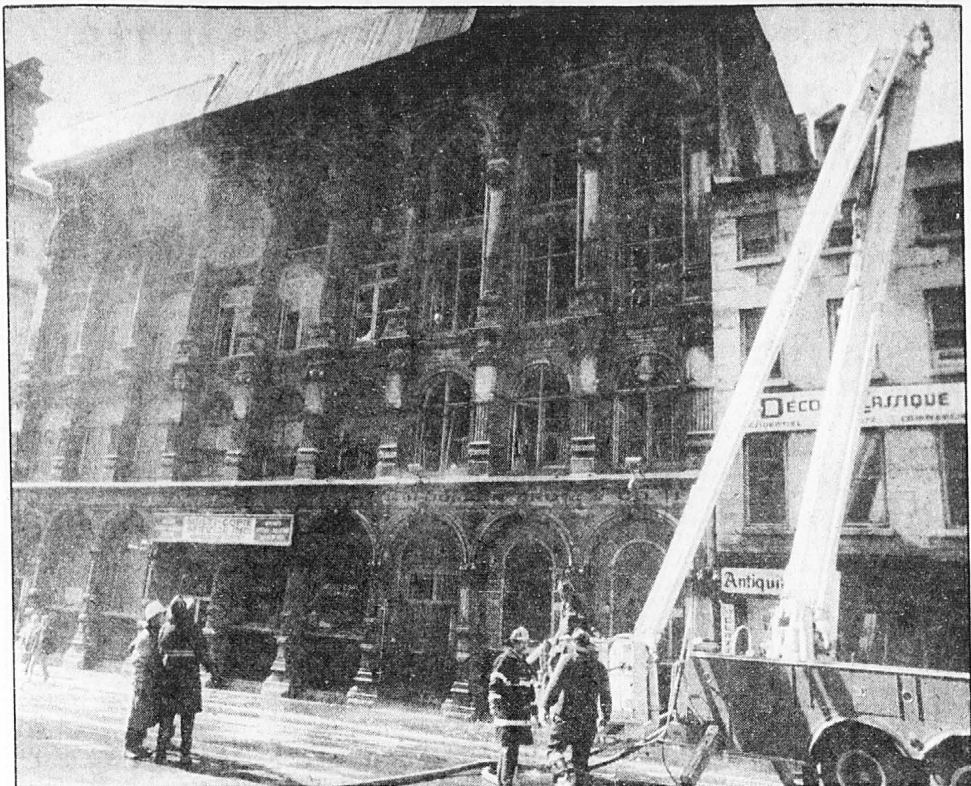
Un incendie qui a nécessité cinq alertes a complètement détruit le Palais du livre, au 408 de la rue McGill dans le Vieux-Montréal. Un édifice ayant valeur de monument et 4 millions de livres perdus. photo Réal St-Jean, LA PRESSE
