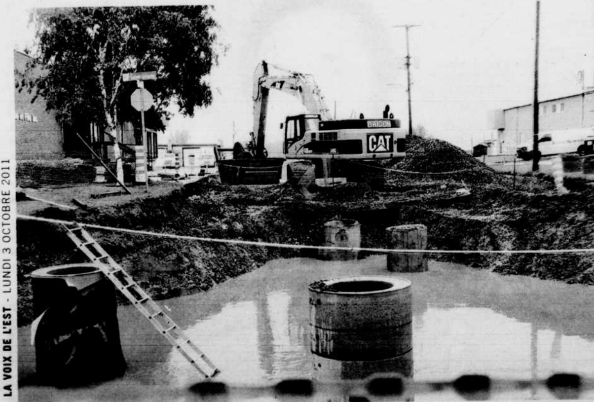
D'importants travaux pour changer les tuyaux d'égout et d'aqueduc sont en cours à l'angle des rues Saint-Urbain et Matton, soit en aval des propriétés dont les sous-sols ont été inondés hier.
