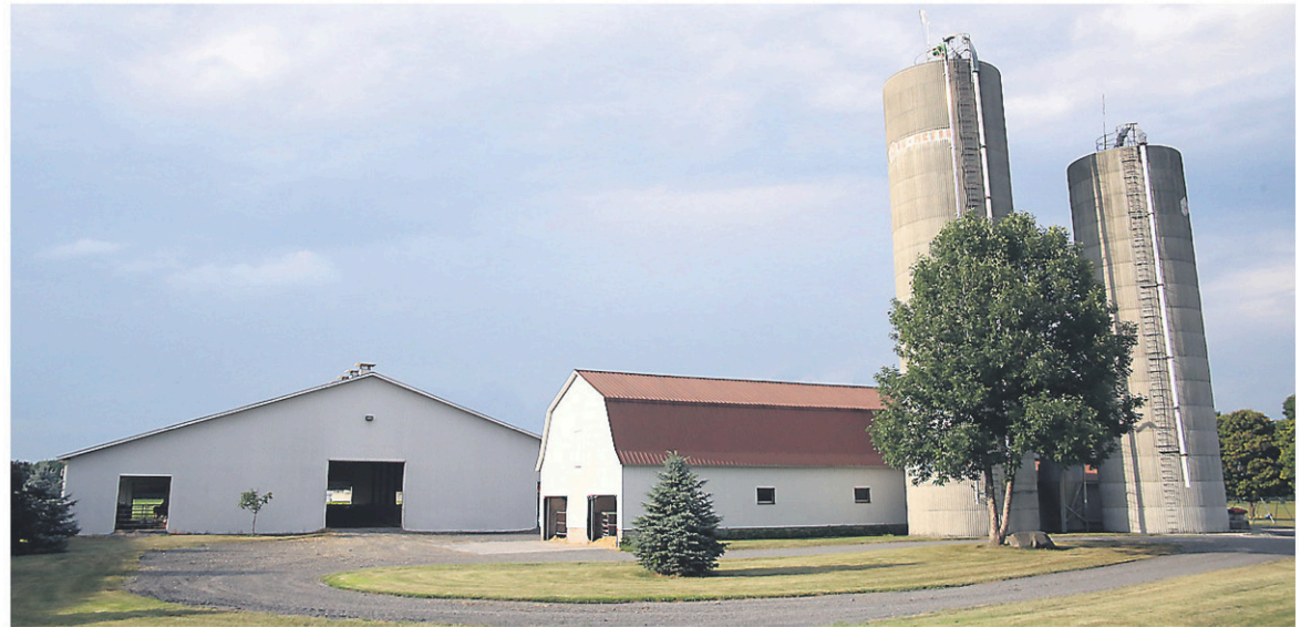
Les dirigeants de la ferme Josef Hüslér à Farnham ont jusqu'au 15 août pour faire des travaux correctifs sur les berges de la rivière Yamaska. — PHOTO CHRISTOPHE BOISSEAU-DION
