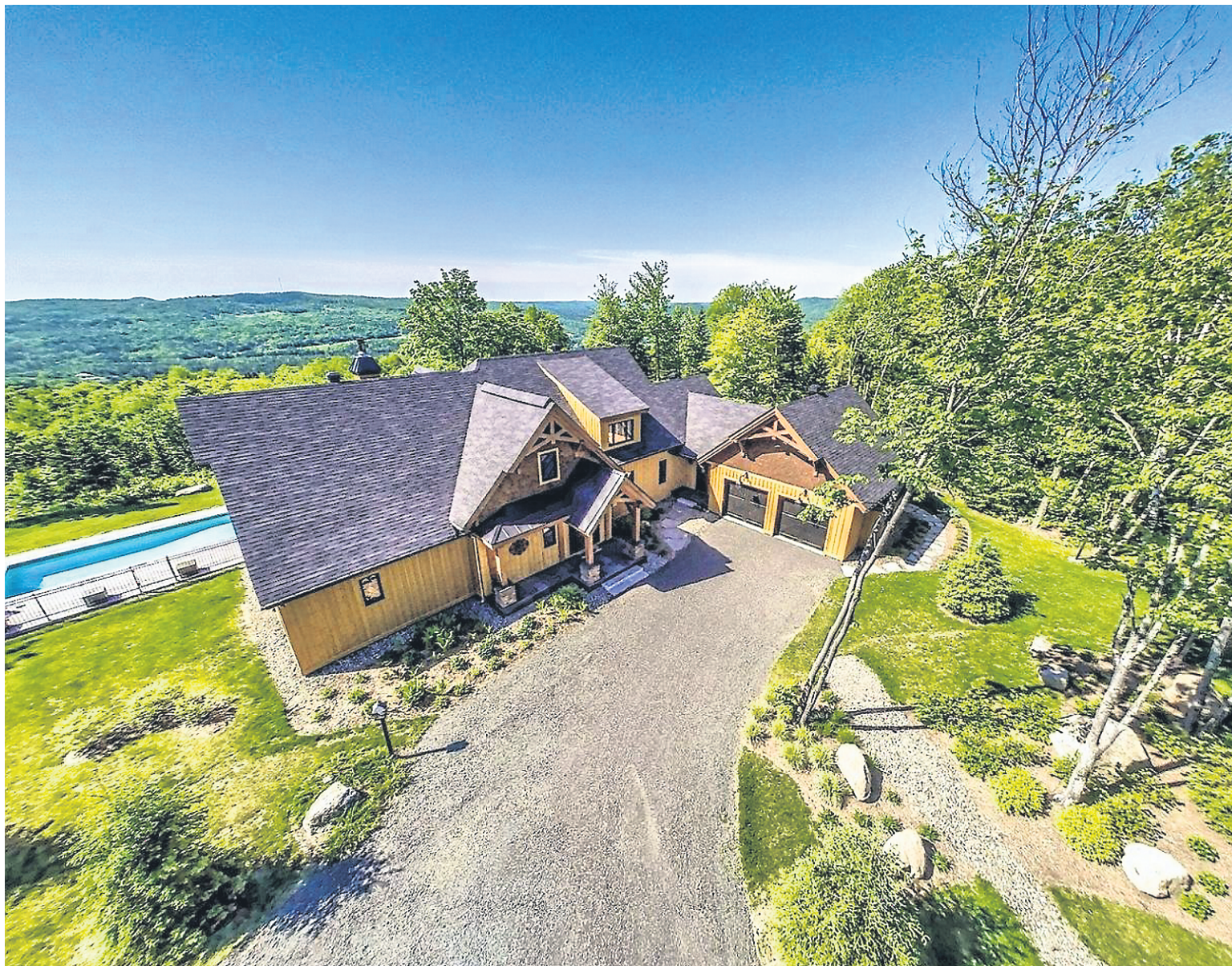
PHOTOS FOURNIES PAR PROFUSION IMMOBILIER La municipalité exige que la maison soit plus près de la rue pour la dérober du regard lorsque l'on regarde la montagne d'en bas. Sur la droite, un garage double communique avec la maison; une fois entré, on accède au sauna.
