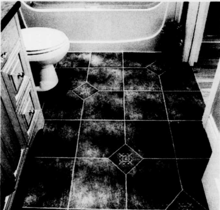
Installé sous les tuiles de céramique, le système de chauffage de plancher dégage une douce chaleur pour les pieds.
