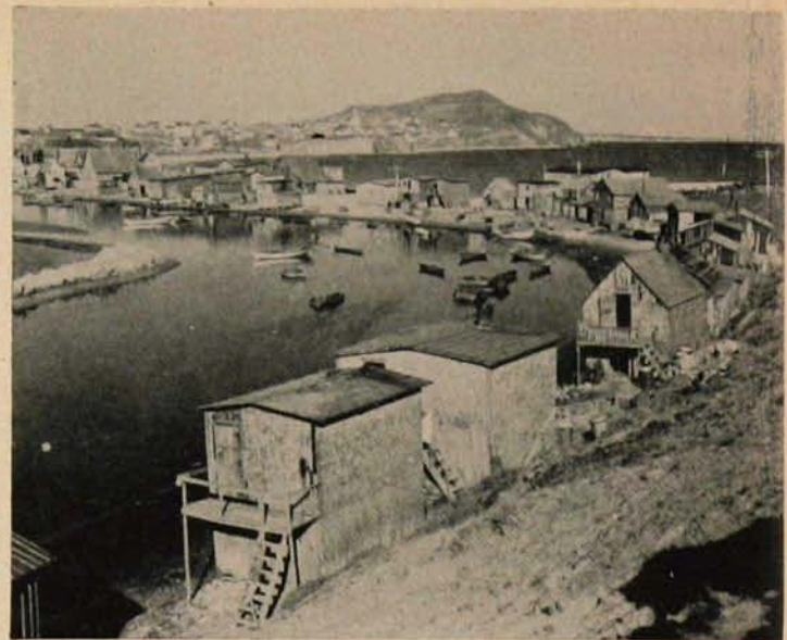
Vue générale de Havre-au-Ber. Tel est l'aspect ordinaire des villages, où on commence enfin à goûter un certain bien-être. Mais il reste fort à faire.
