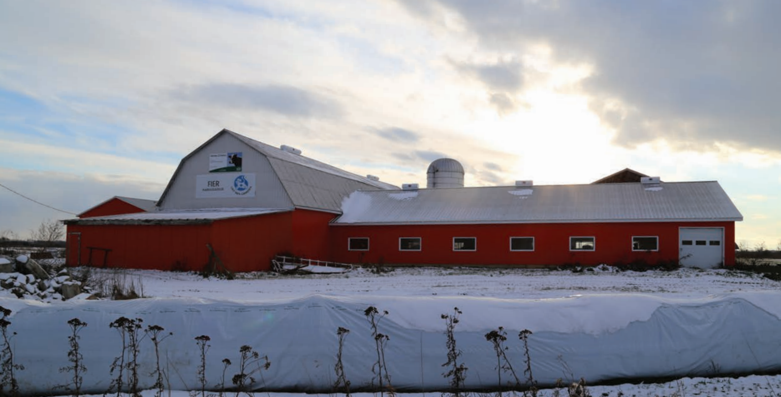
Les problèmes ont commencé lorsque la nouvelle partie de l'étable (à droite) a été construite.
