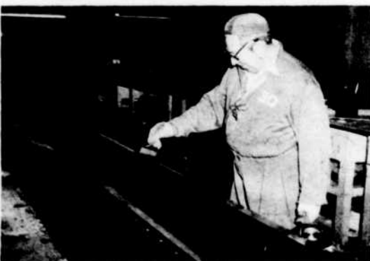
M. Benoit Vaillancourt, préposé au recouvrement de caoutchouc à l'usine de chlore.
