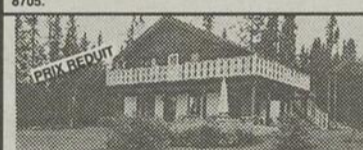
376, lac Clair, très belle résidence, garage double, quai, sur 2 étages, à voir. Serg Tremblay, 548-1525.
