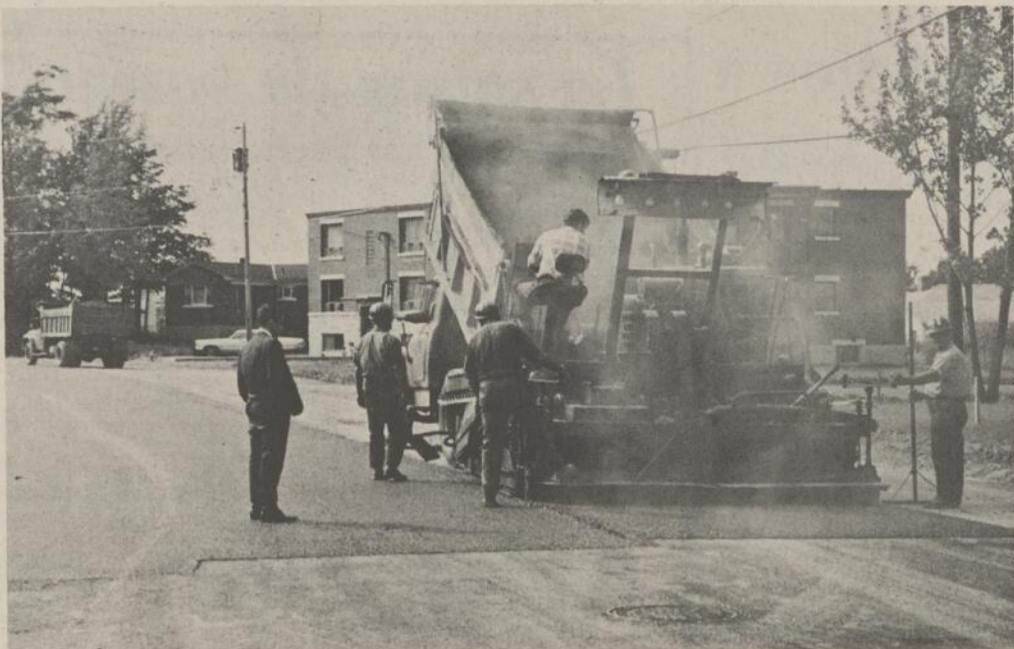
PAVAGE DES RUES-- Les employés de la firme Comet Construction, de Cowansville, exécutent présentement des travaux de pavage de rues dans les quartiers de la municipalité de Cowansville. On remarque sur la photo les employés au travail sur la rue Brown.
