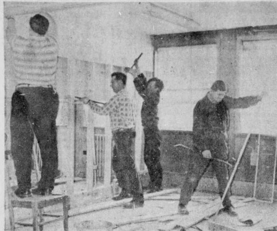
LES CHEVALIERS SONT A L'OEUVRE. — Désireux d'occuper leur nouveau local le plus tôt possible, nombreux sont les Chevaliers de Colomb du conseil no 2088, de Thetford Mines, qui consacrent leur journée hebdomadaire de congé aux travaux de transformation présentement en cours dans l'édifice en question. La photo ci-haut montre d'ailleurs quelques-uns de ces travailleurs bénévoles. (Photo La Tribune, Thetford Mines)
