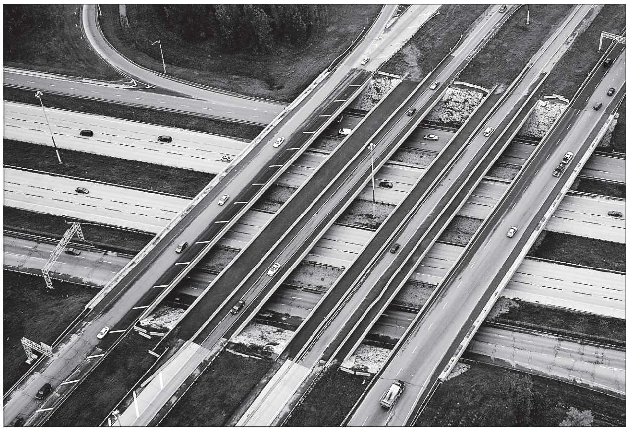
Vue aérienne de la jonction de l'autoroute 440 et de la 13, photographiée le 2 octobre, soit deux jours seulement après l'écroulement du viaduc de la Concorde.
