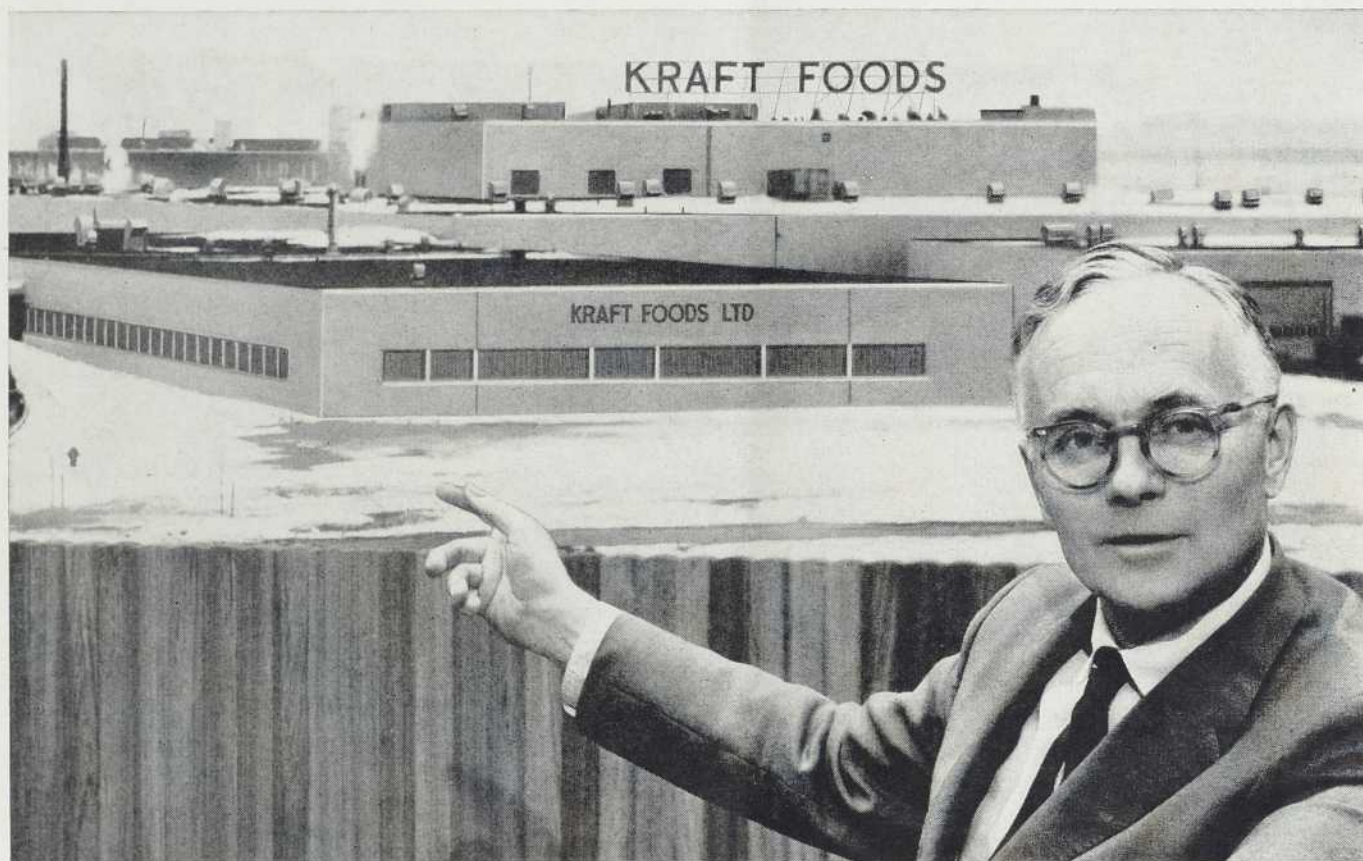
M. J.-L. Bieler, Ing. P., Ingénieur-chef, pointe à la photo agrandie de la nouvelle usine. Les bureaux, au premier plan, ont des fenêtres, bien qu'entièrement climatisés. Il n'y a aucune fenêtre dans l'usine même.
