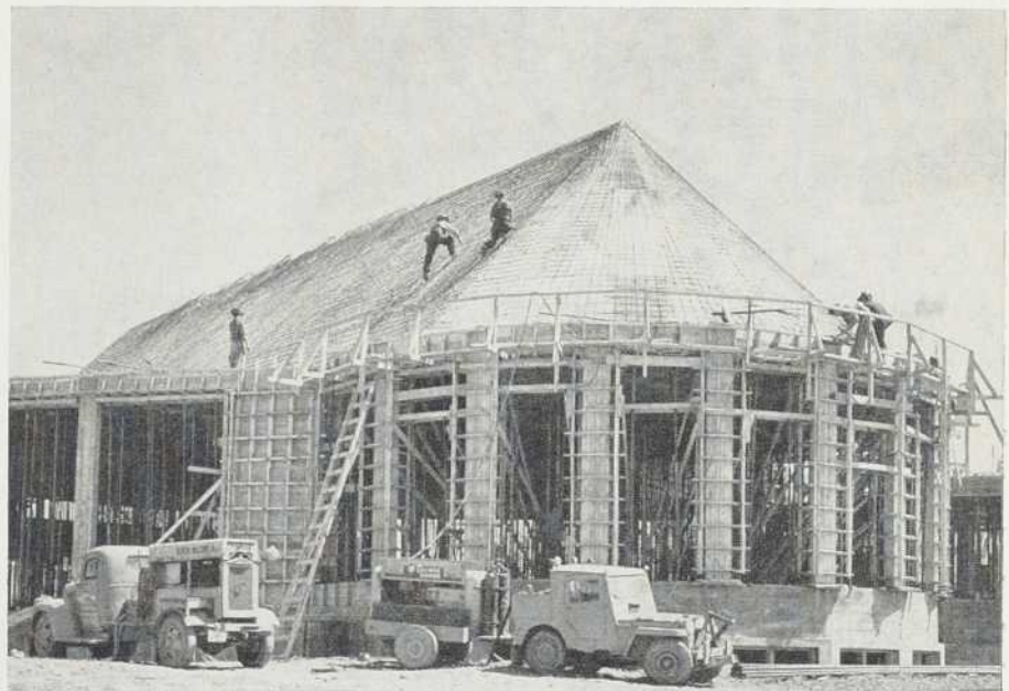
Fig. 5 — La voûte vue de l'arrière.
