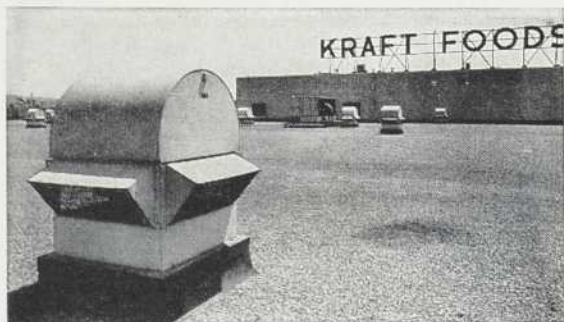
87 ventilateurs de toiture à éventails centrifuges, tel celui-ci, furent installés sans encombrer l'espace à l'intérieur de l'édifice.
