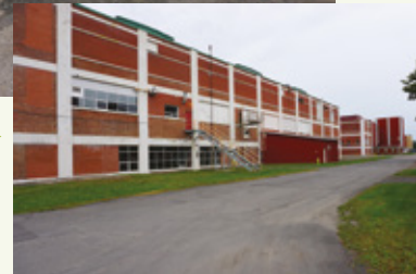
▲ Vues du site de l'ancienne usine Canadian Celanese, Drummondville Photos : L'Enclume
