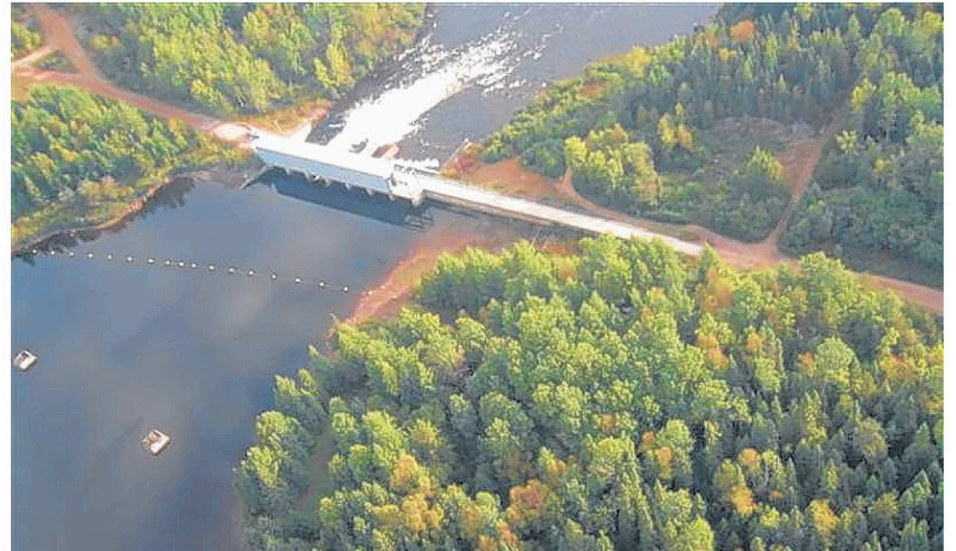
Une petite centrale qui ressemble à ce que serait Manouane Sipi. (Photo gracieuseté)
