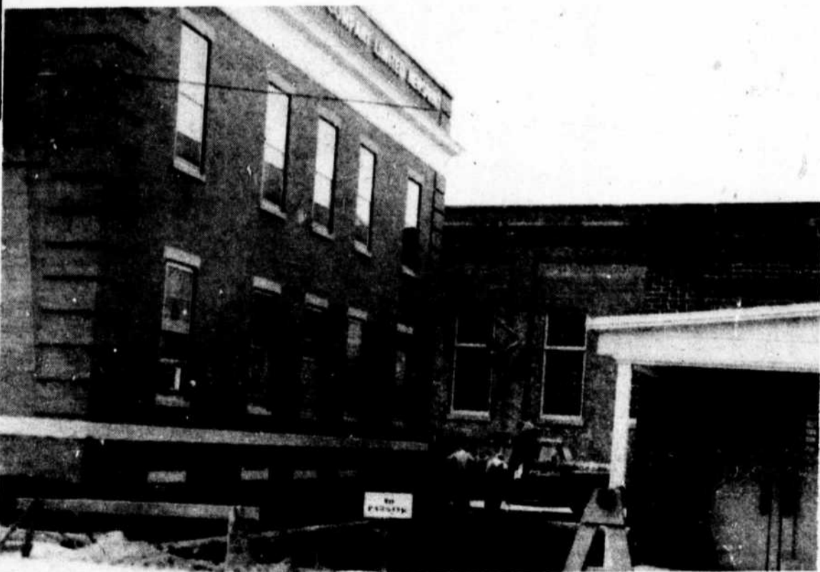
Les travaux d'agrandissement au coût approximatif de $250,000, à la compagnie MacLaren à Masson, sont maintenant en marche. La photo ci-haut nous fait voir les débuts de ces travaux. La firme Polloch-McGibbon de Montréal est en charge de cette construction.
