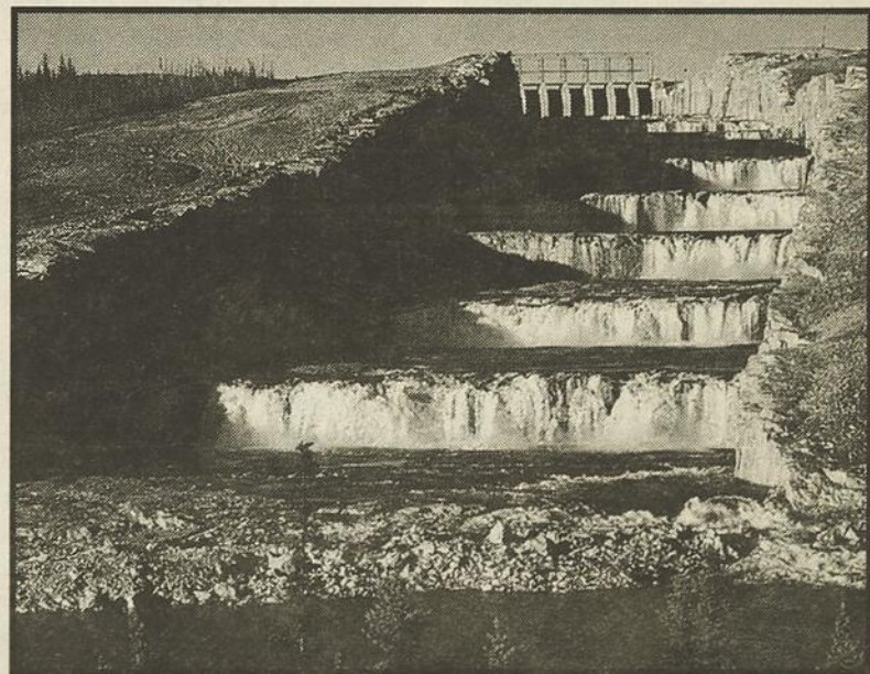
L'évacuateur de crues de LG 2 en action, une scène datant des années 1980 qui ne risque pas de se répéter trop souvent.
