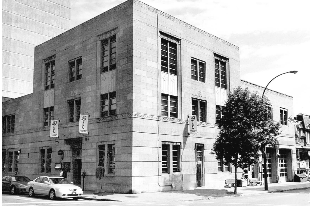
La transformation du Resto-Lounge poste 25 a le mérite d'avoir respecté les caractéristiques architecturales d'origine de l'immeuble, malgré le changement de fonction.
