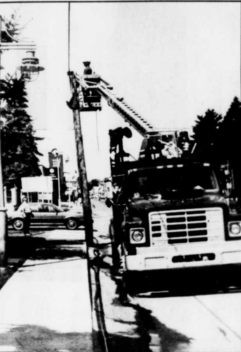
Les employés spécialisés de Bell Canada et d'Hydro-Québec ont procédé au cours de la journée d'hier à l'enlèvement de poteaux sur le boulevard Saint-Laurent, à Louiseville, dans le cadre du programme de revitalisation du centre-ville. Pour ce faire, il a fallu l'étroite collaboration des automobilistes qui ont dû s'abstenir de stationner leur véhicule des deux côtés de cette voie publique.
