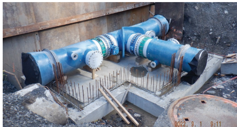
Construction d'une chambre de vannes souterraines coulée en place. Vue sur la tuyauterie et des accessoires qui se retrouvent dans cette chambre souterraine.
