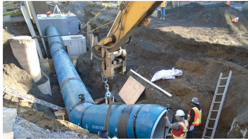
Installation en tranchée d'une conduite d'eau potable en béton-acier précontraint de 1 050 mm de diamètre. D'autres infrastructures sont en construction en arrière plan.
