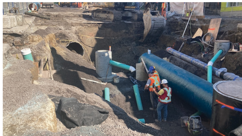
Vue d'ensemble sur une tranchée partagée où plusieurs infrastructures sont en reconstruction (conduite d'eau principale, conduite d'eau secondaire, regard d'égouts, puisard et câbles électriques). Un bel exemple d'un projet intégré.
