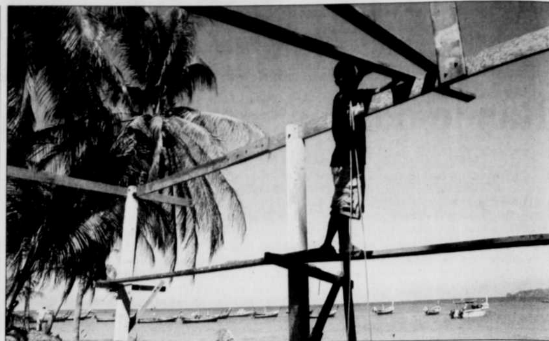
À Bang Tao, une ville située sur l'île de Phuket, en Thaïlande, un ouvrier travaille à la reconstruction d'une maison détruite par un tsunami le 26 décembre dernier.
