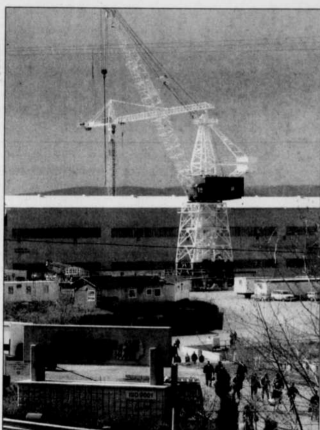
Le chantier menacé de la Davie
