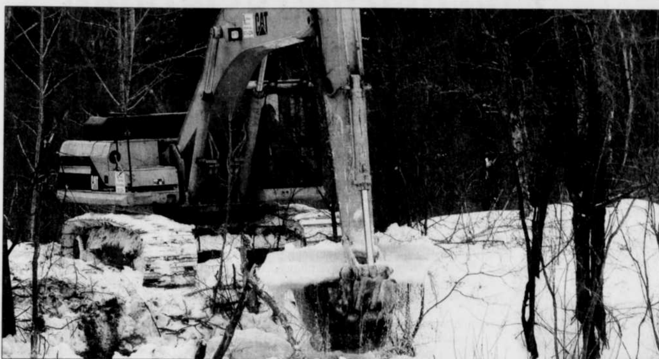
Les travaux avancent lentement sur la rivière Sainte-Anne.
