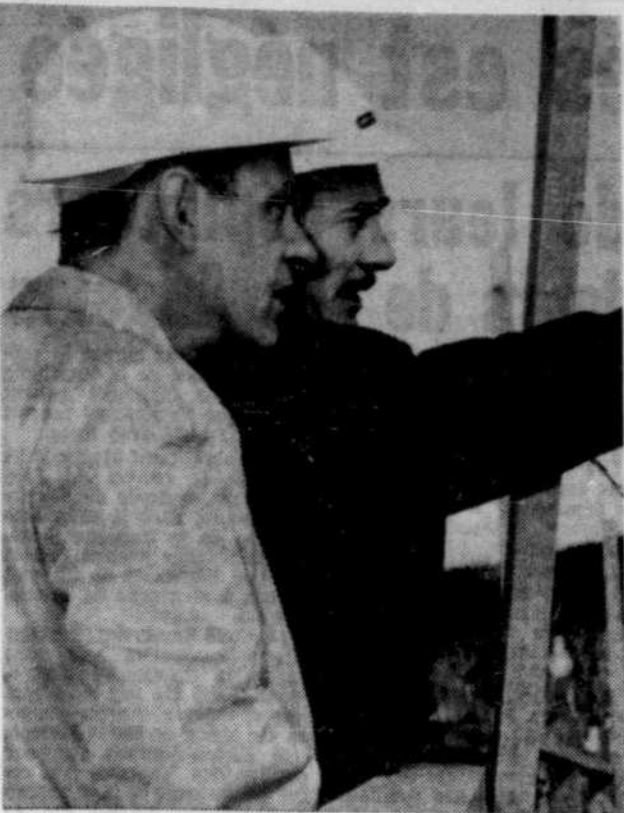
M. René Lévesque, ministre des ressources naturelles, a visité les travaux de construction des barrages Manic 5 et Manic 2, sur la Manicouagan, mardi et mercredi. Il écoute avec grand intérêt les explications de M. Serge Godbout, ing.-p., directeur du chantier de Manic 5 qui lui indique l'un des aspects importants des gigantesques entreprises qui occupent des milliers d'hommes.
