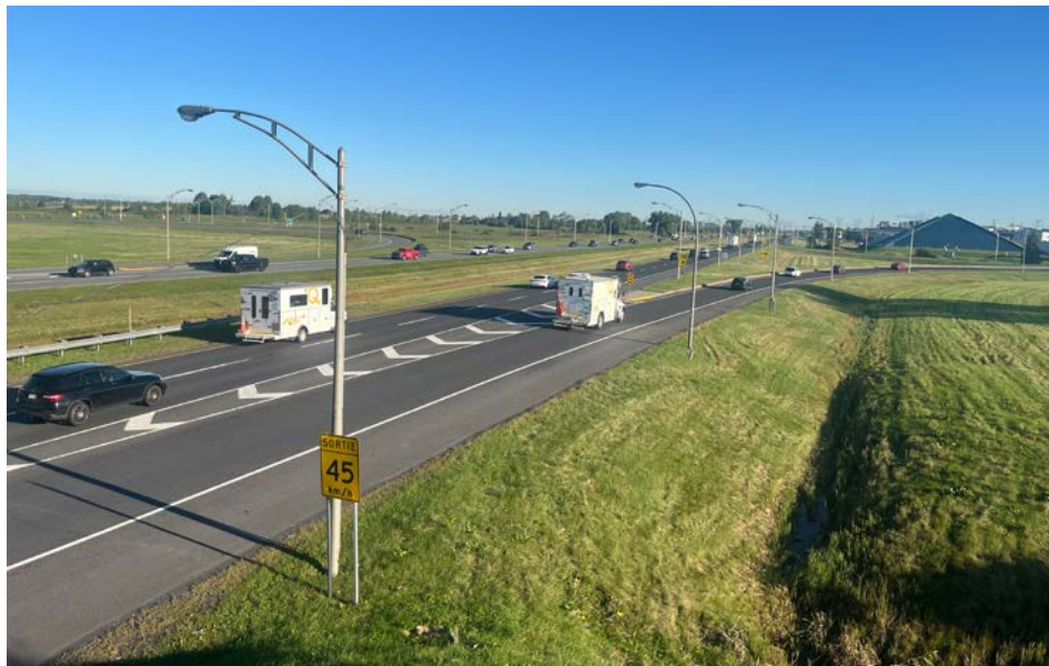
Depuis plusieurs années, l'élargissement de l'autoroute 30 est souhaité. (Photo : Marie-Pier Ouellet)
