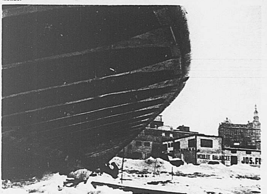
Pour donner plus de stabilité au bateau, l'ingénieur a décidé de fermer ces alvéoles, sous le bateau. Pour exécuter ce travail, les ouvriers s'installent tout bonnement sur la glace, sous le bateau.
