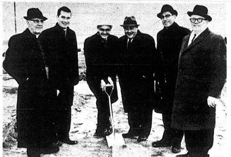
Plusieurs personnalités civiles et religieuses assistaient samedi dernier à l'ouverture des travaux de construction de l'usine "Les Produits d'Acier Lacolle Ltée", à Lacolle. Dans la photo ci-dessus, nous remarquons, de gauche à droite, Mgr Louis Lafortune, curé de Lacolle; MM. Ian Watson député fédéral; Georges Picard, surintendant de l'usine; Albert Morin, maire du village de Lacolle; Paul-Emile Landry, président de la Chambre de Commerce de Lacolle et Maurice Boissonneault, maire de la paroisse de Lacolle.
