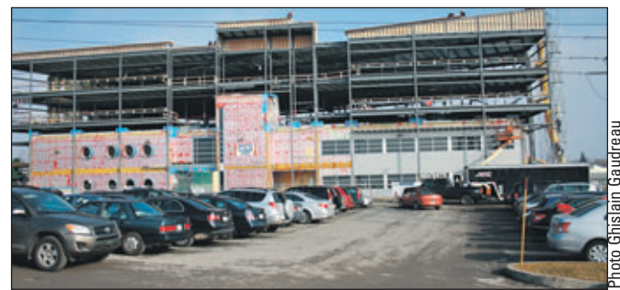
Les travaux progressent bien à l'immeuble de la Clinique Saint-Louis comme en témoigne cette photo prise il y a quelques jours.
