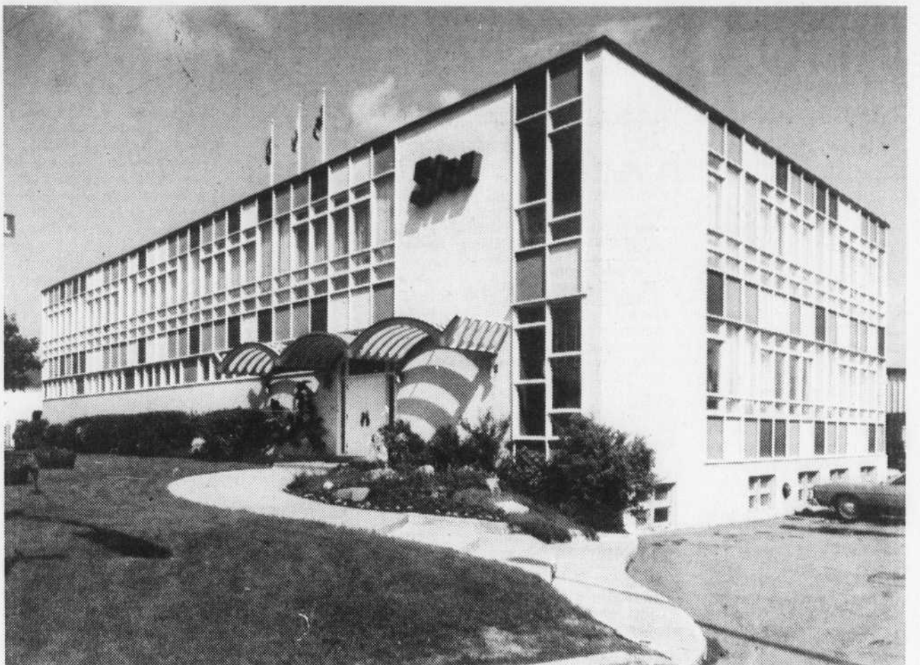
Une vue du siège social du groupe SICO Inc. Sur ce terrain de 125,000 pieds carrés, l'entreprise groupe atelier, entrepôts et bureaux, à Giffard, dans la banlieue de Québec.
